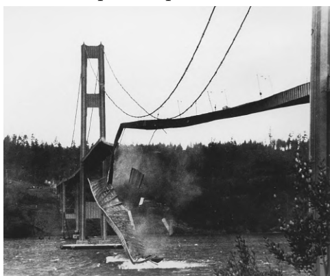
Figura 8 – Colapso da ponte Tacoma Narrows.
