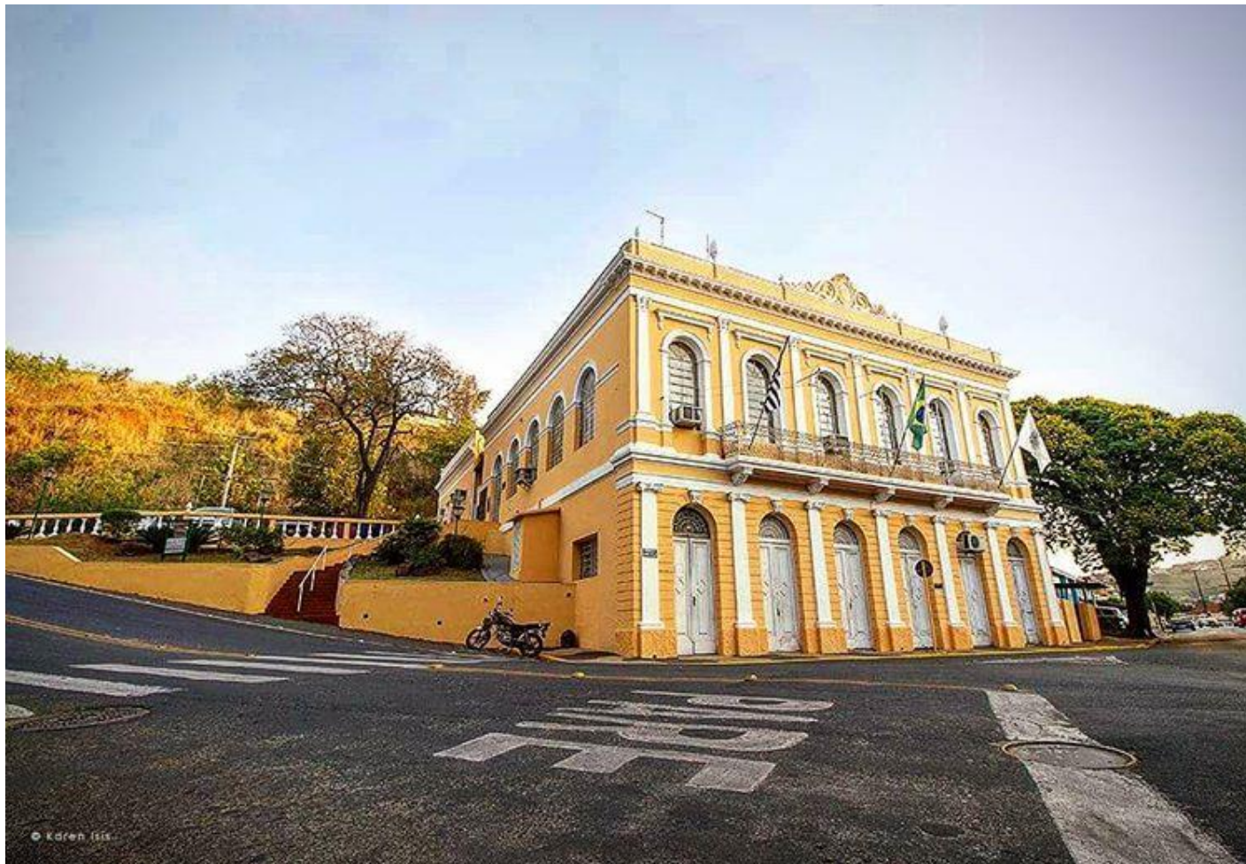
Figura 85 - Paço municipal de Pedreira.
