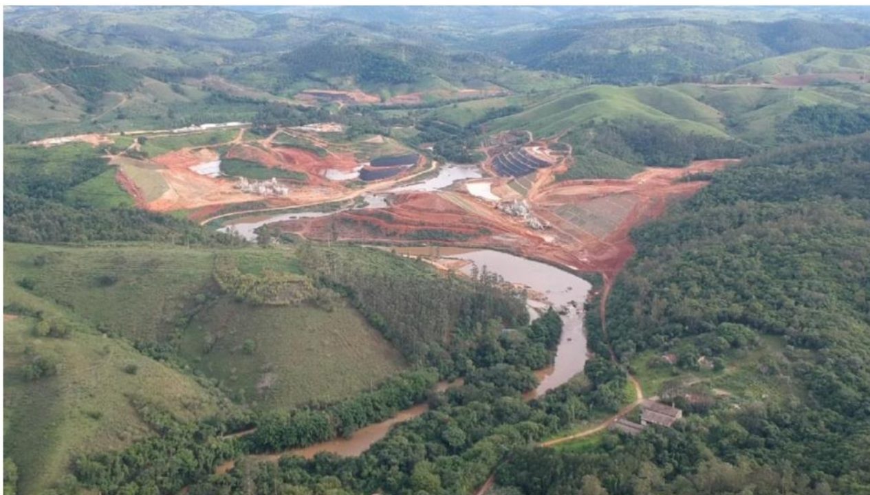
Figura 53 - FES Córrego da Linde/Isoladores Santana impactado pelo canteiro de obras da barragem de Pedreira.
