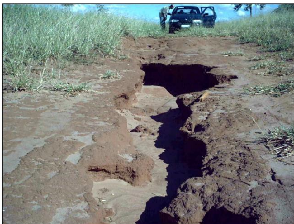
Figura 15: Ravina em estágio inicial localizada no leito de estrada vicinal abandonada. Autor: Frascoli, A. C. Data: 02/05/03. FONTE: PDA, 2004.
