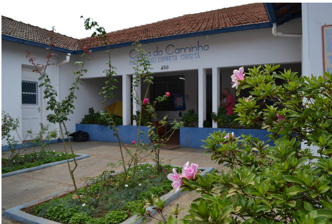
Figura 2: Entrada do prédio principal (fonte: arquivo Casa do Caminho).
