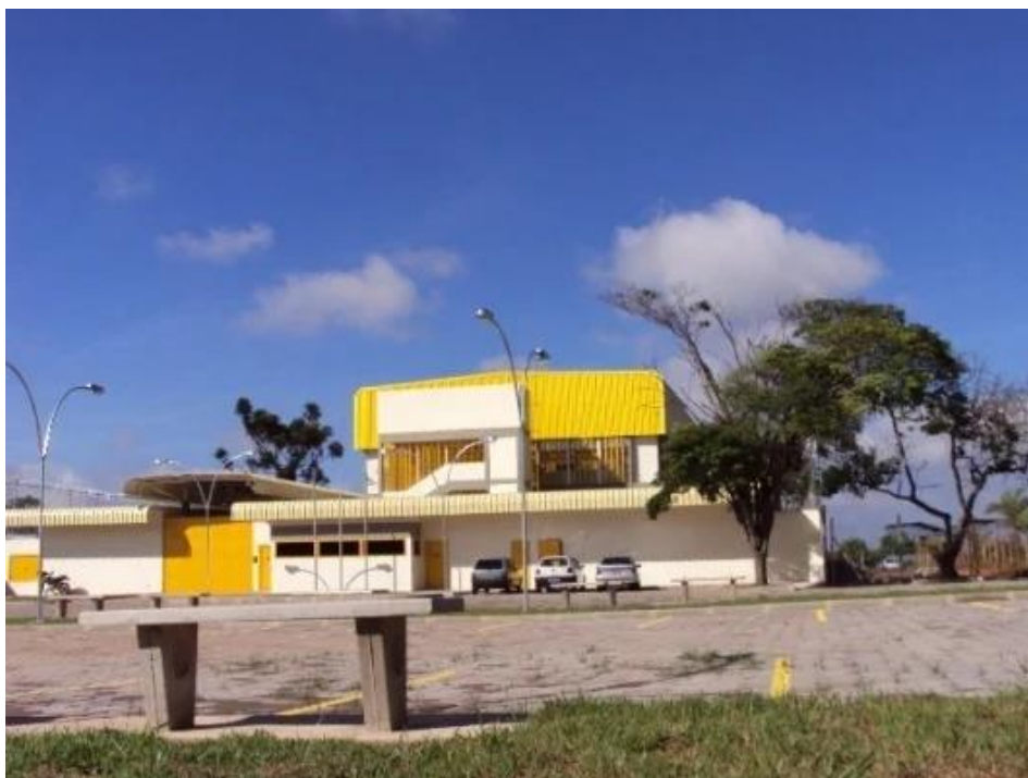
Figura 2: Fundação CASA São Carlos.
