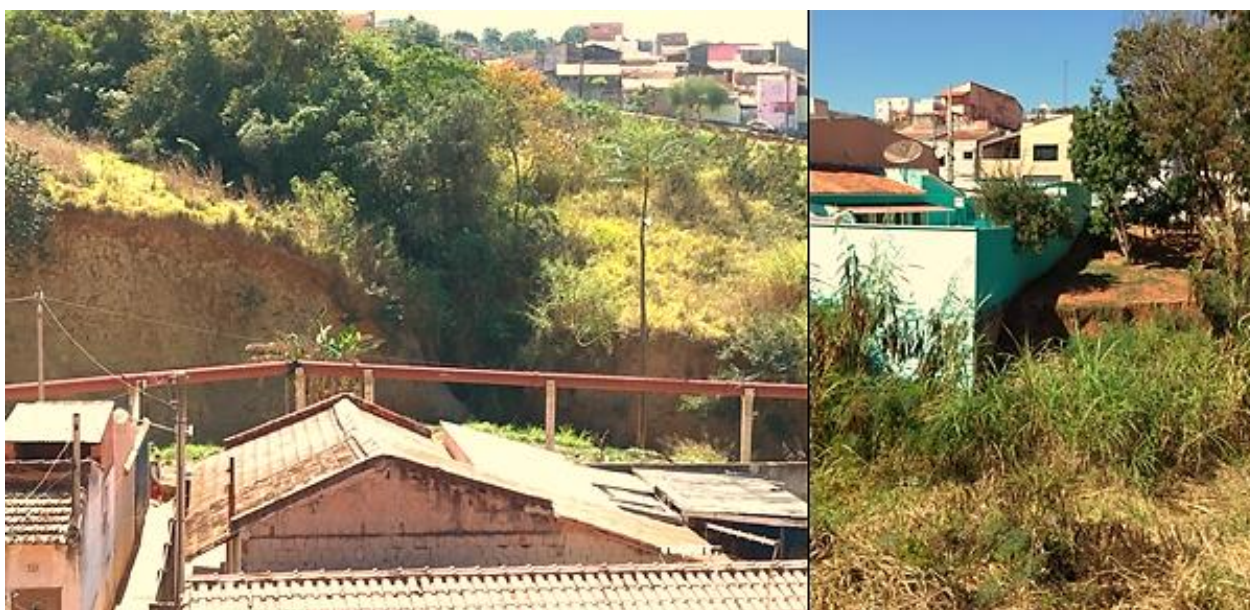
Figura 35. Ocupações irregulares em taludes expostos próximos ao Córrego Matadouro Velho, no município de Tatuí, classificando área de risco.
