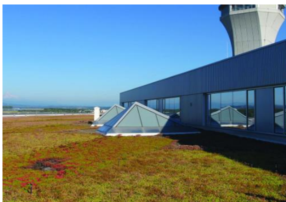
Figura 12 – Telhado verde em Portland
