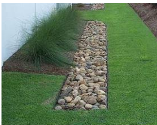
Figura 7 – Trincheira de infiltração
