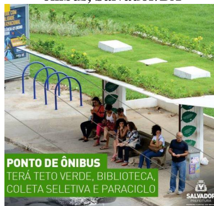
Figura 13 – Telhado verde em ponto de ônibus, Salvador/BA
