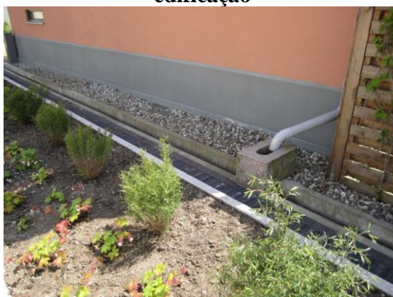
Figura 8 – Trincheira ao longo da edificação
