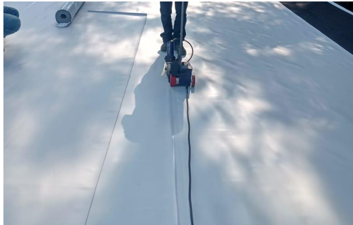
Figura 14: Manta de PVC - solda entre mantas com soprador térmico automático
