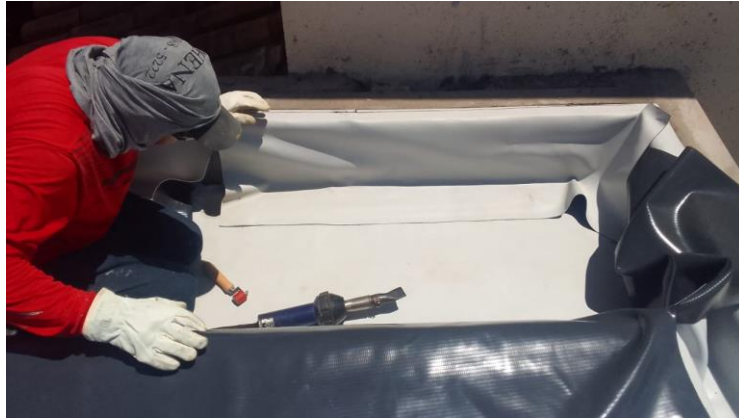
Figura 13: Aplicação de manta de PVC com soprador térmico manual
