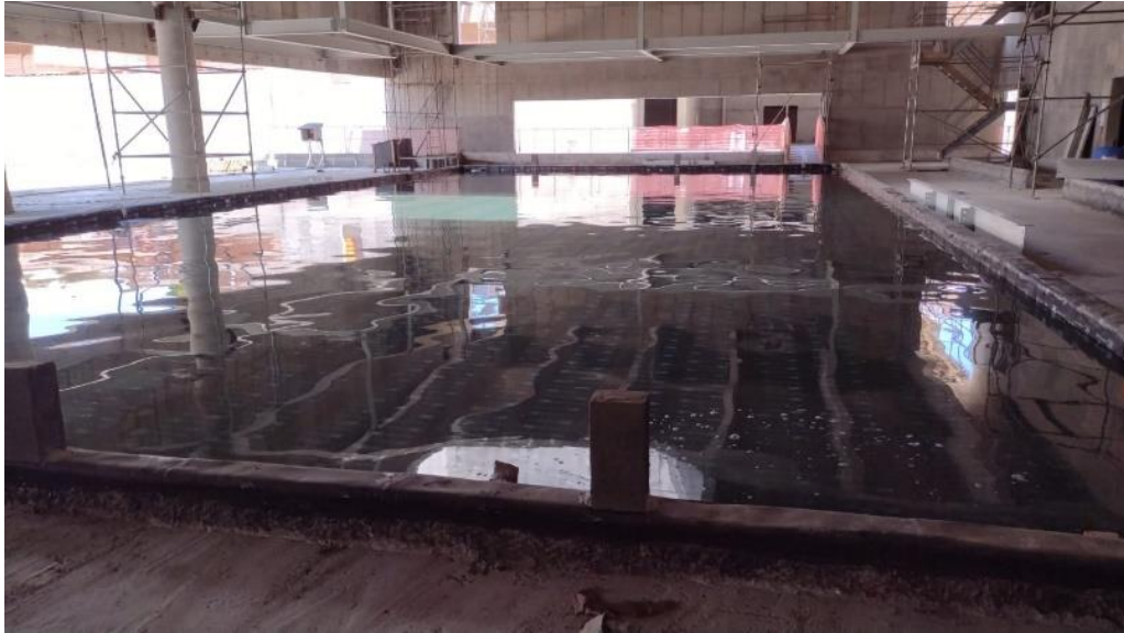
Figura 9: Manta Asfáltica - teste de estanqueidade com lâmina d'água
