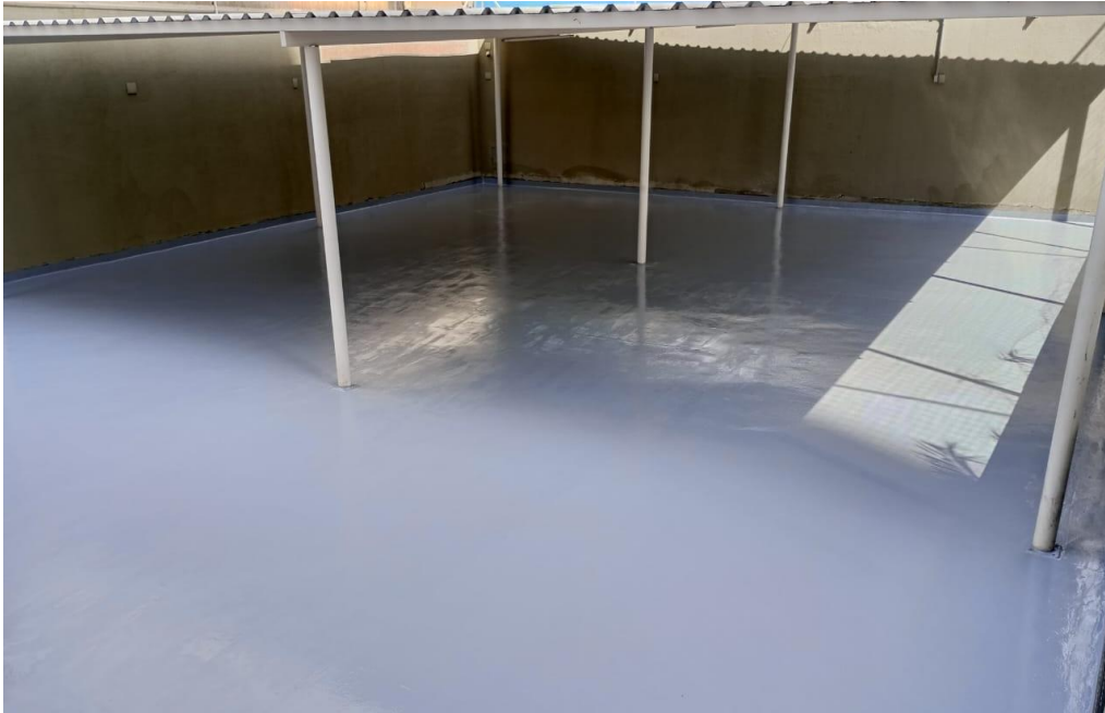
Figura 20: Membrana de Poliuretano Transitável em estacionamento
