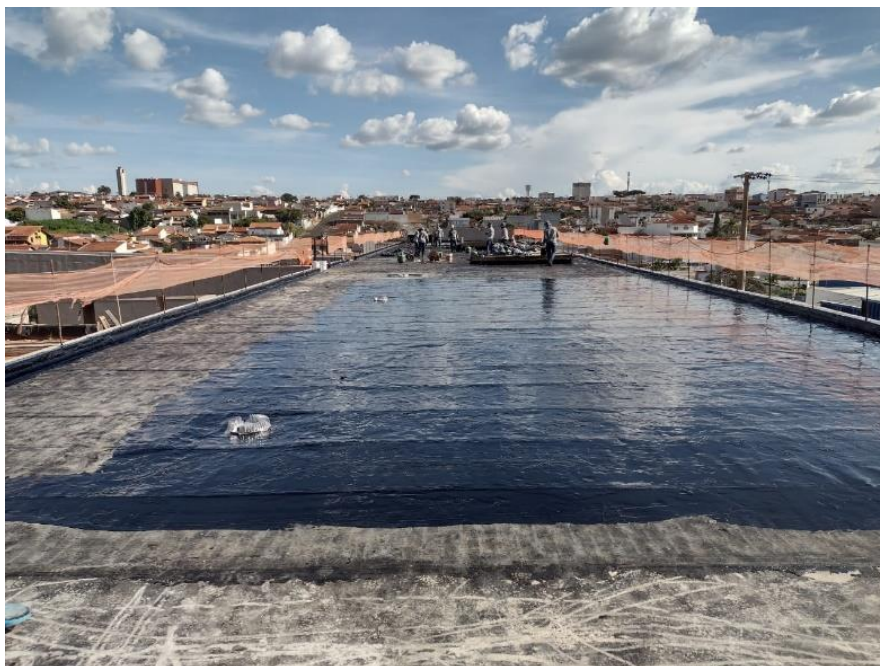
Figura 8: Manta Asfáltica - banho de asfalto oxidado
