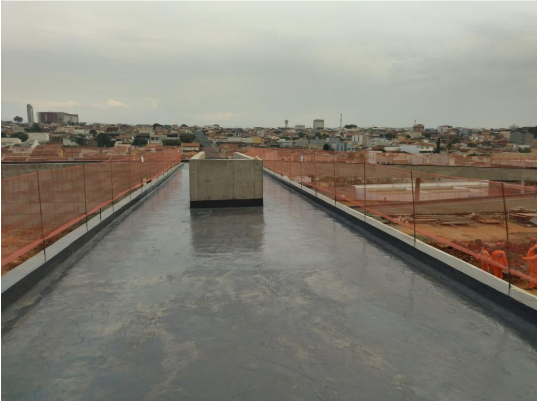
Figura 18: Membrana de Poliuretano em passarela
