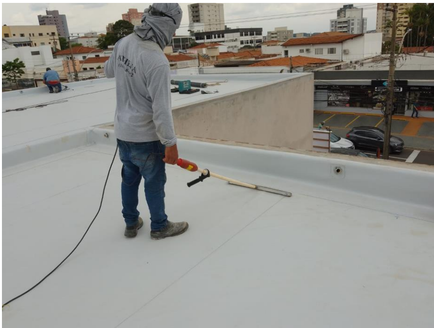
Figura 17: Manta de PVC - teste com detector de descontinuidades (Holiday Detector)
