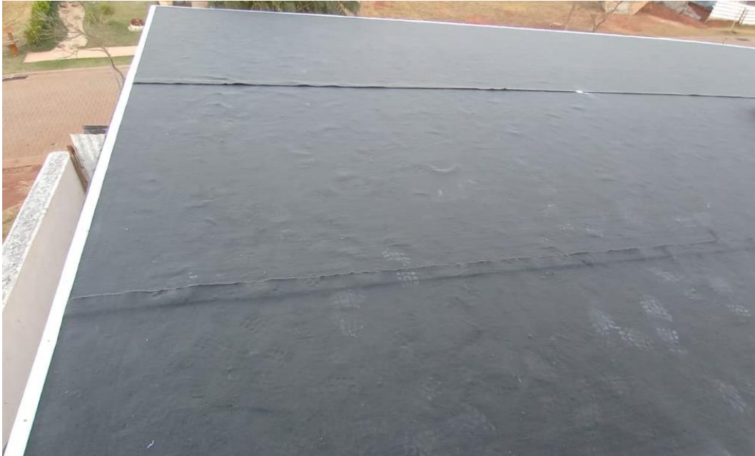
Figura 11: Manta de PVC - geotêxtil
