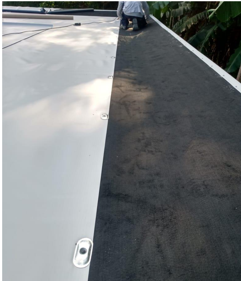
Figura 12: Manta de PVC – fixação distribuidores de esforço
