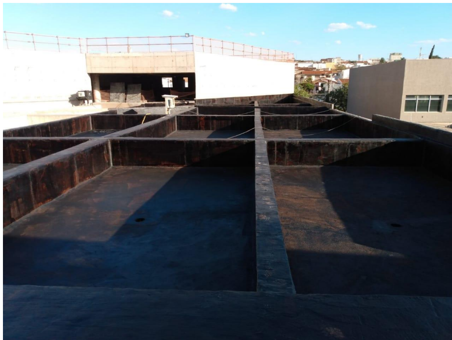
Figura 6: Manta Asfáltica - primer asfáltico
