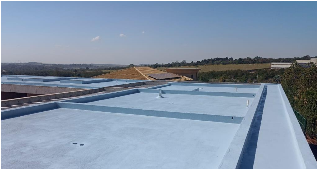
Figura 19: Membrana de Poliuretano em laje de cobertura
