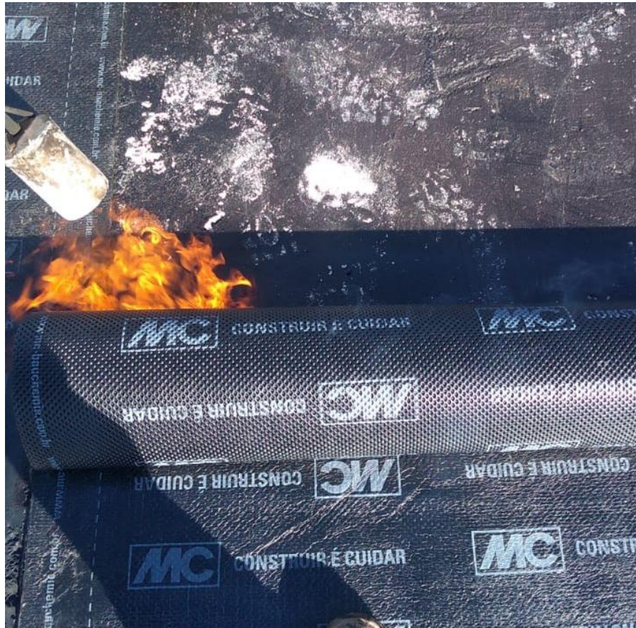
Figura 7: Aplicação de manta asfáltica aderida à maçarico
