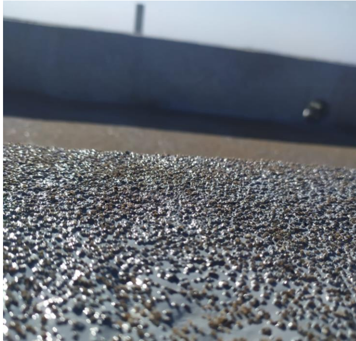
Figura 22: Membrana de Poliuretano com aspersão de agregado com granulometria controlada em laje de cobertura
