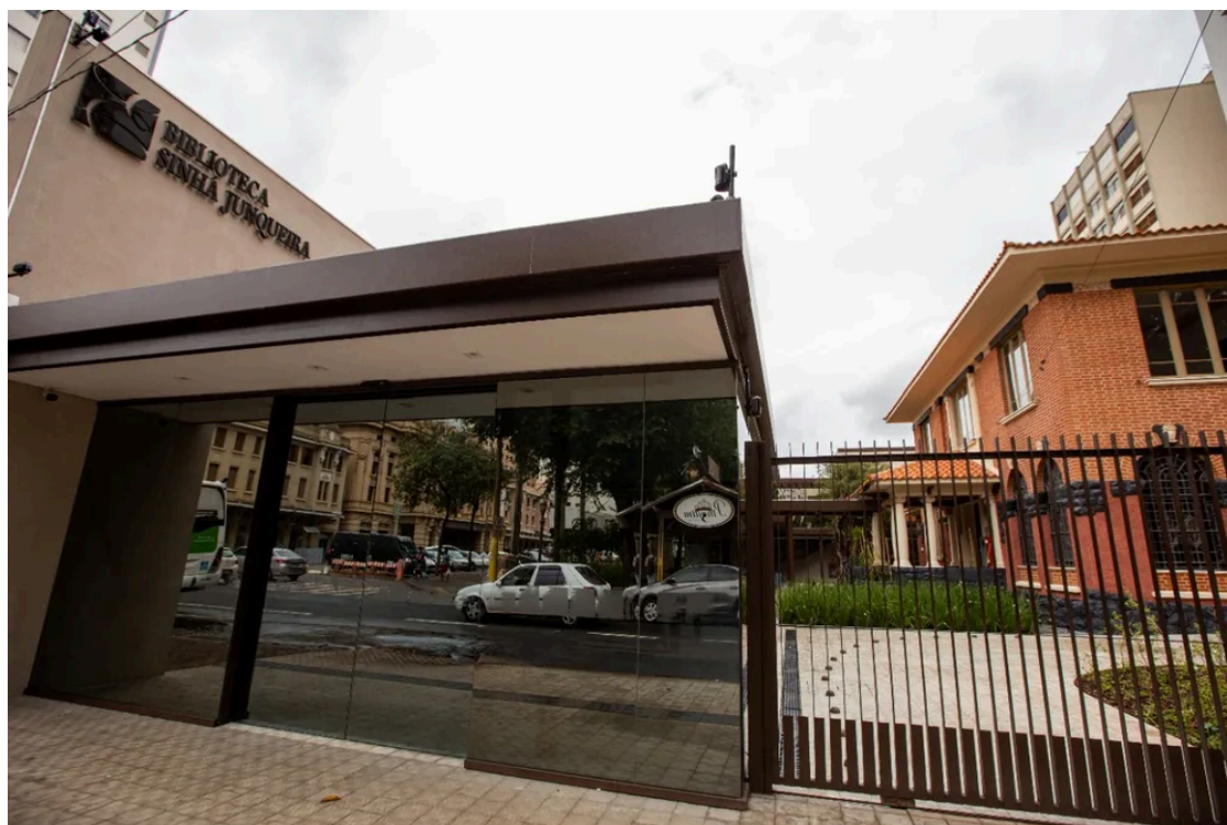
Figura 3 - Fachada e área externa da Biblioteca Sinhá Junqueira após reforma
