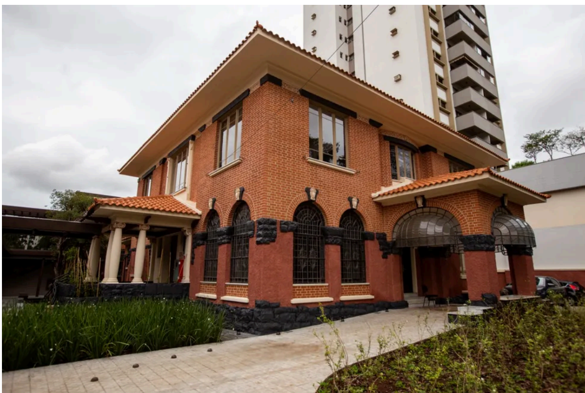
Figura 2 - Casarão da Biblioteca Sinhá Junqueira após reforma
