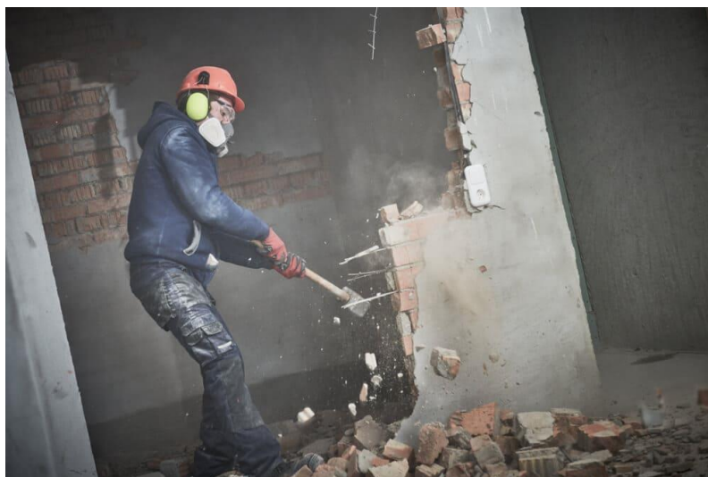
Figura A.1 – Demolição manual com marreta
