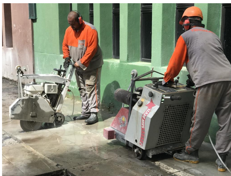
Figura A.9 – Demolição de superfície de concreto com fio diamantado
