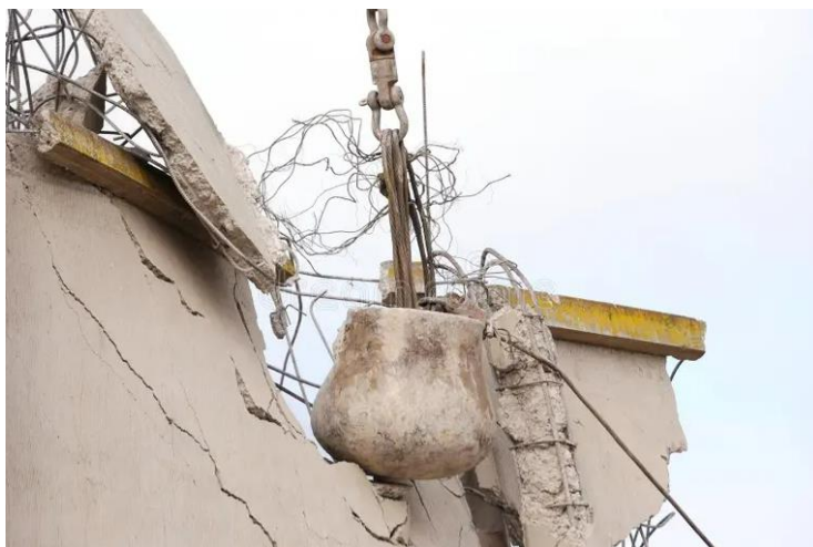
Figura A.3 – Demolição mecânica utilizando bola de demolição
