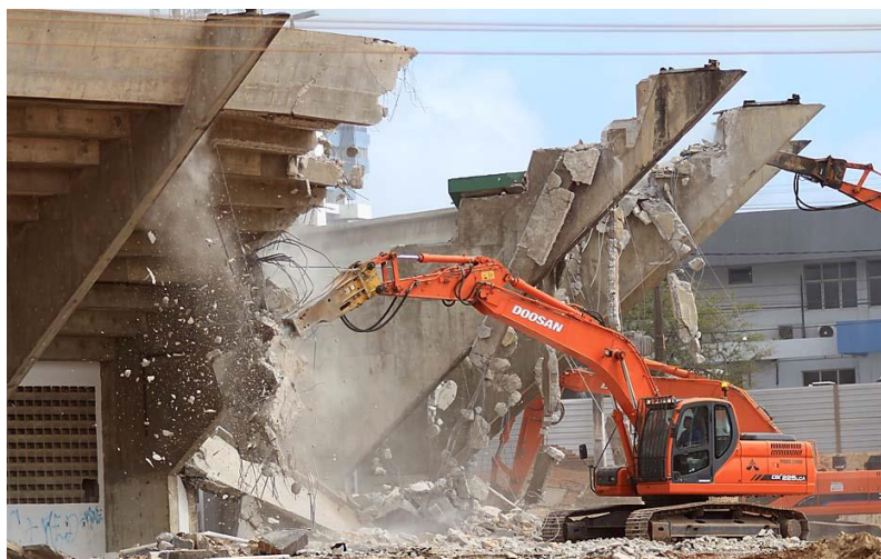
Figura A.2 – Demolição mecânica utilizando escavadeira com rompedor
