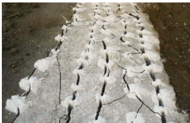
Figura A.5 – Demolição química por argamassa expansiva
