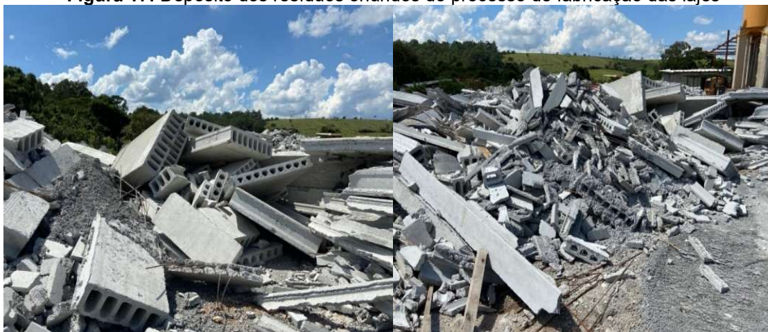
Figura 17: Depósito dos resíduos oriundos do processo de fabricação das lajes
