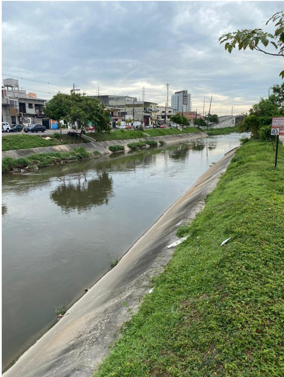
**Figura 16:** canal retificado e canalizado aberto e com margens concretadas, pouca vegetação arbórea nas margens. Emerson Costa Barbosa, Fevereiro, 2022.
