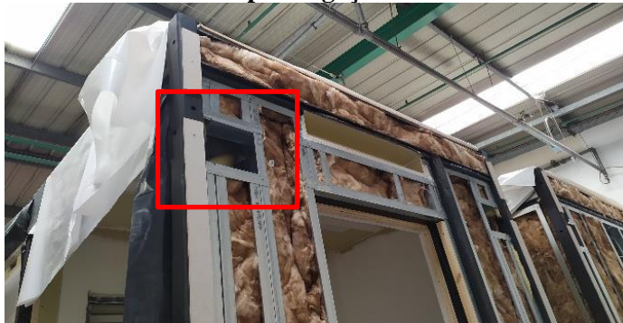
Figura 35 - Detalhe de sistema para ligação entre os módulos – Empresa A
