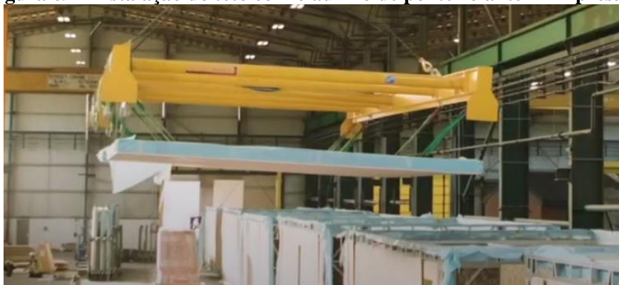
Figura 69 - Instalação do teto com o auxílio de ponte rolante – Empresa C
