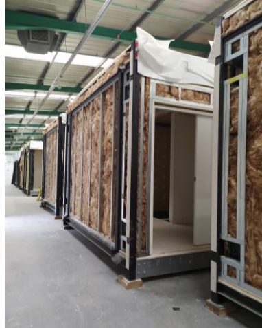
Figura 32 - Módulos com estrutura principal em aço e com painéis formados por perfis de aço leve revestidos com isolamento térmico – Empresa A
