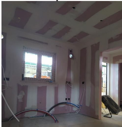
Figura 66 - Ventilador posicionado para auxiliar na secagem da massa de acabamento – Empresa C
