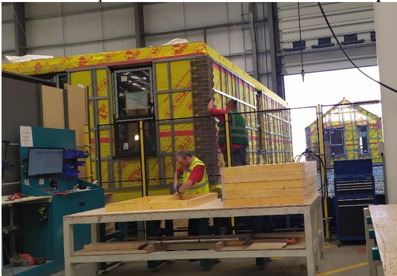
Figura 93 - Instalação do acabamento externo do módulo – Empresa F
