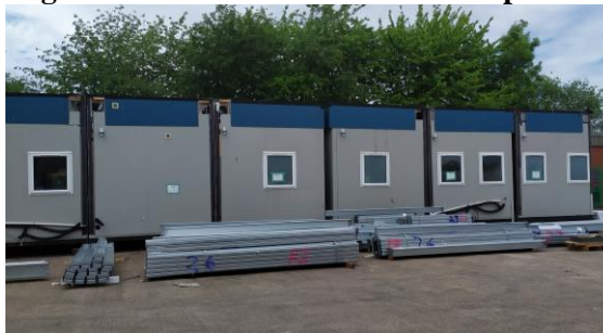
Figura 34 - Módulos acabados – Empresa A
