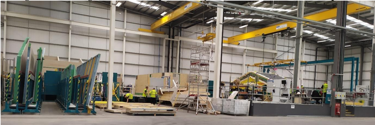
Figura 92 - Montagem de elementos para formação do módulo volumétrico – Empresa F
