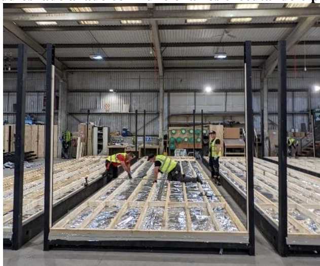
Figura 86 - Módulos lado a lado com funcionários executando o piso – Empresa D
