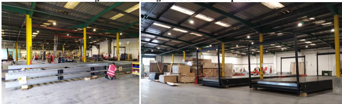
Figura 37 - Montagem do chassi – Empresa A
