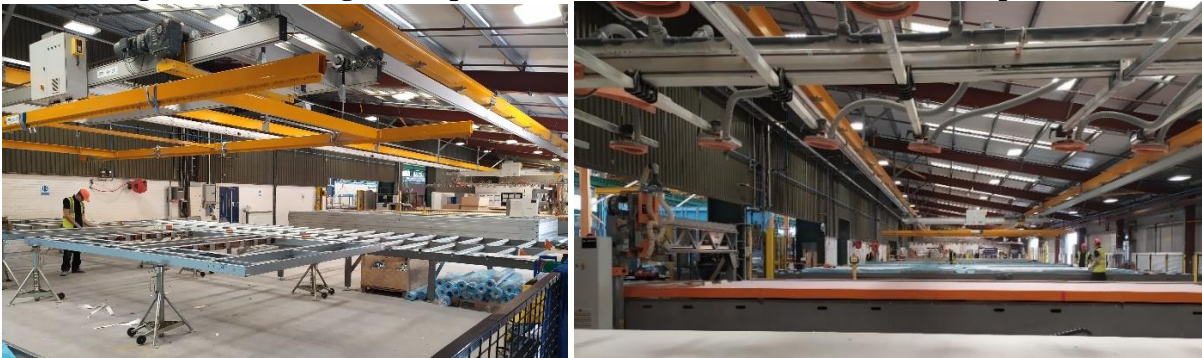
Figura 78 - Montagem dos painéis de fechamento e das divisórias – Empresa C
