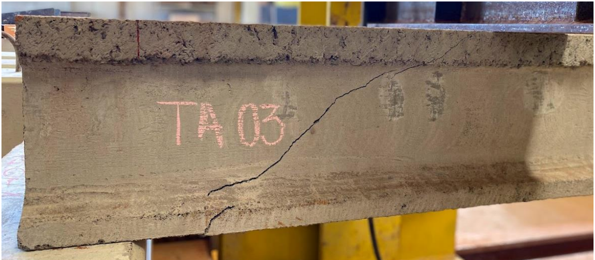
Figura 4.50: Fissura identificada na ruptura da peça TA 03 – Lado B.
