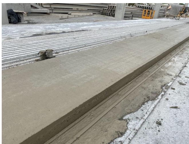
Figura 2.10: Concretagem de laje alveolar em pista de produção fabril.
