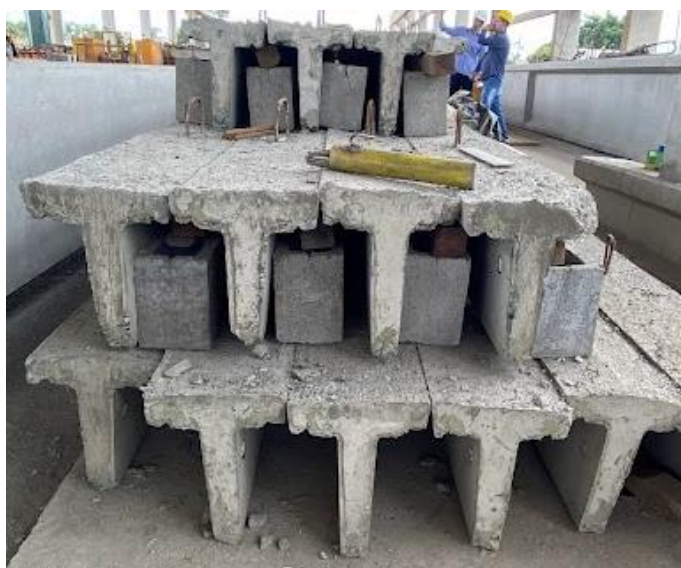
Figura 2.5: Armazenamento das terças.
