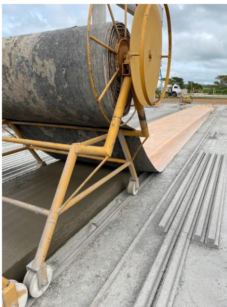
Figura 2.11: Endurecimento e cura do concreto de laje alveolar.
