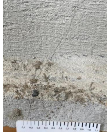
Figura 4.11: Evolução da fissuração TA 02.
