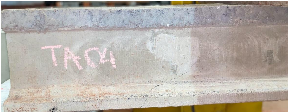
Figura 4.53: Fissura identificada na ruptura da peça TA 04 – Lado A.
