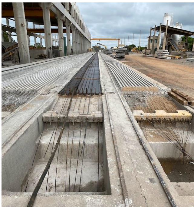
Figura 2.8: Pista de concretagem e posicionamento de cabos de protensão.
