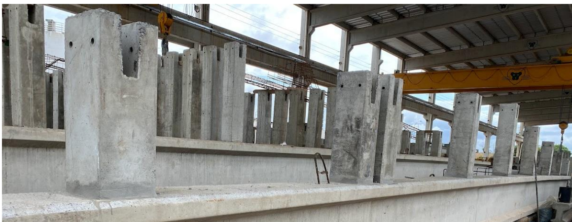
Figura 2.7: Extensão dos pilaretes ao longo da viga pré-moldada de concreto.
