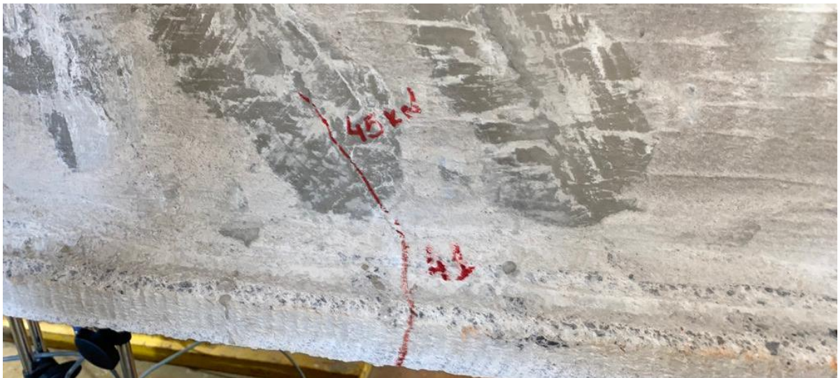
Figura 4.24: Abertura diagonal TA 06.
