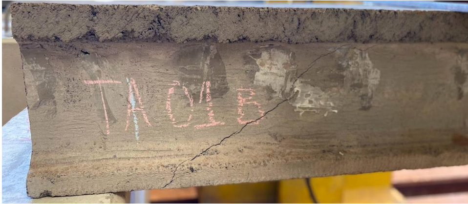
Figura 4.38: Fissura identificada na ruptura da peça TA 01 – Lado B.
