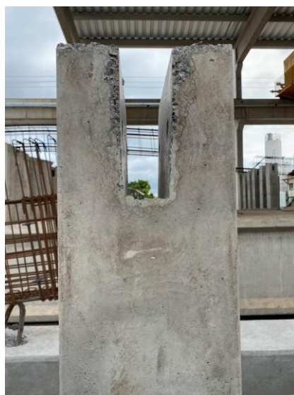
Figura 2.6: Ponto de fixação da terça T.
