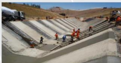
Segmento de canal entre reservatório Mandantes e EBV-3
