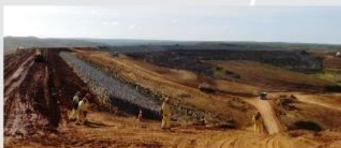
Reservatório Jati – vista do dique e maciço
