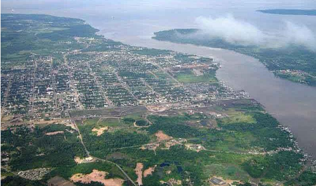
Figura 6 - Vista aérea de parte do município de Santana-AP
