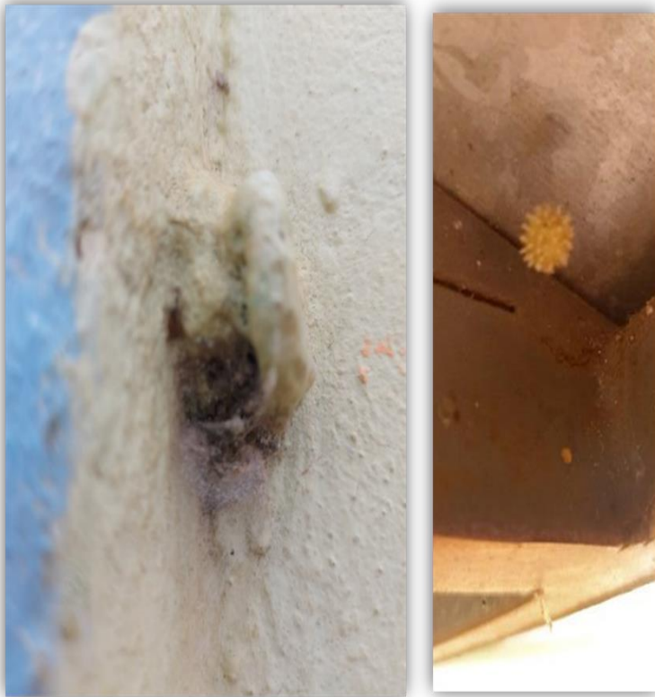
Imagem 37 – Descobertas na varanda da sala referêcia
