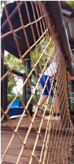
Imagem 42 – Ponte do parque do Sesc São Carlos
