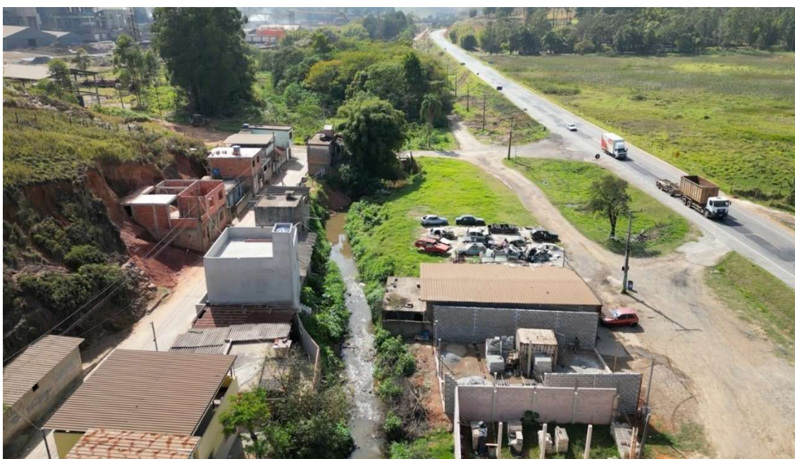
Figura 31. Imagem aérea de toda a extensão do trecho C5 do canal natural.
