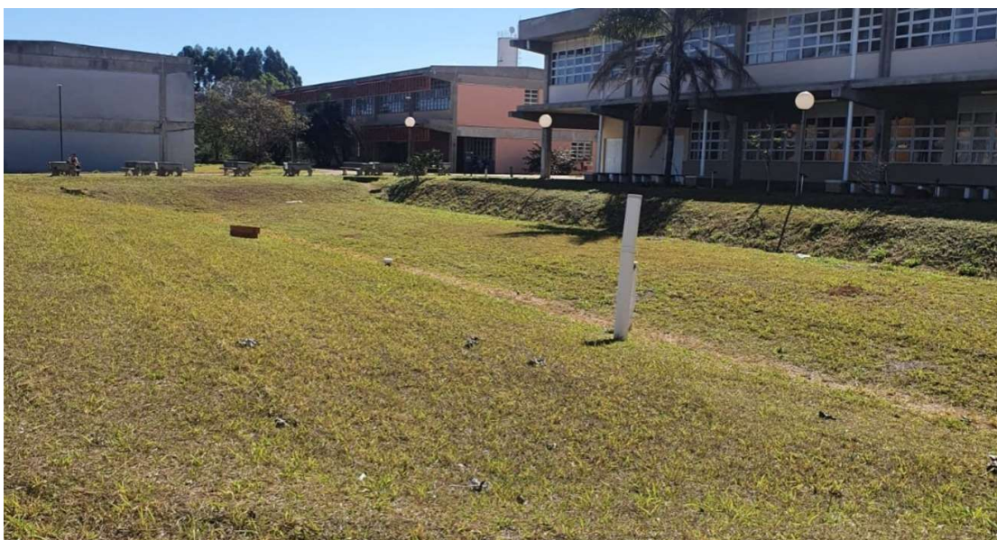
Figura 8. Trincheira de infiltração, associada a uma vala de infiltração, implantada no campus da UFSCar em São Carlos-SP.
