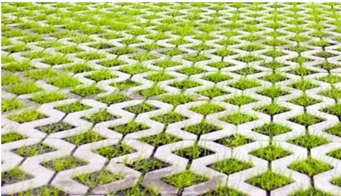
Figura 6. Pavimento permeável com cobertura de gramínea.
