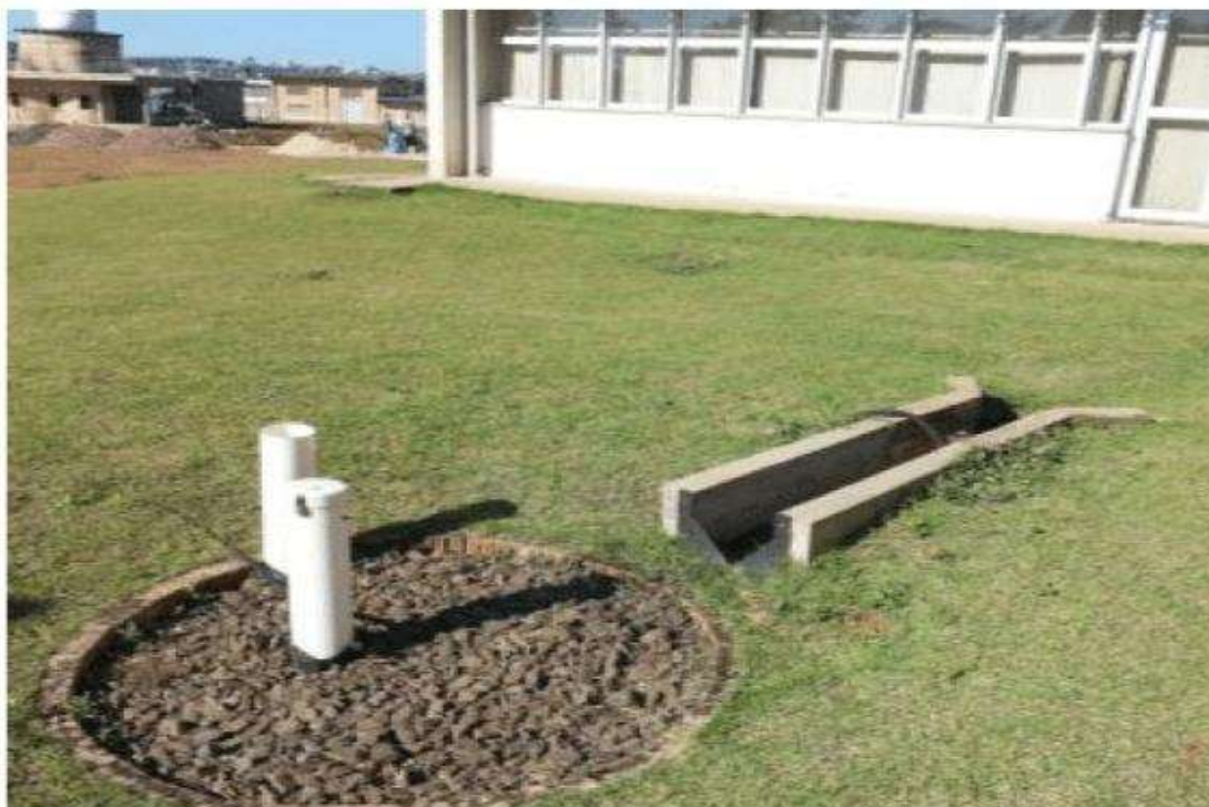
Figura 11. Poço de infiltração campus UFScar - São Carlos-SP.
