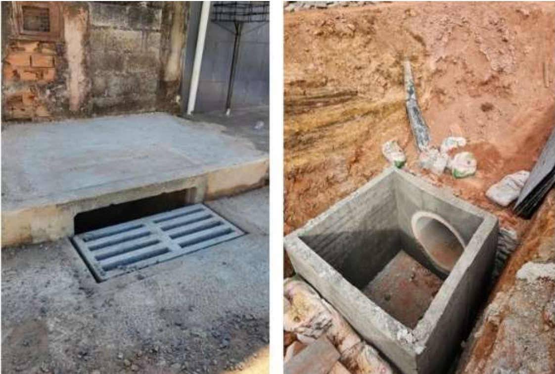
Figura 3. Boca de Lobo combinada com grelha implantada no bairro Amazônia (à esquerda) e caixa de passagem em concreto armado implantada no bairro Salvaterra (à direita).
