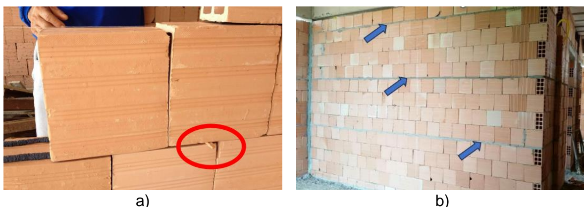
Figura 2 – Soluções adotadas no assentamento de alvenaria de vedação
