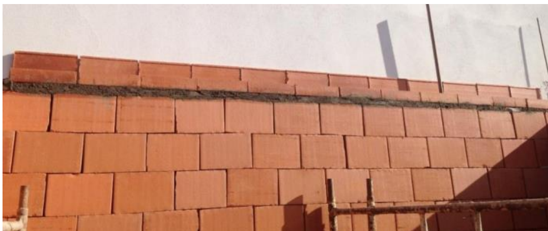
Figura 4 - Execução da última fiada com argamassa cimentícia
