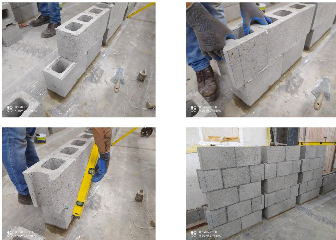
Figura 66 – Construção das pequenas paredes
