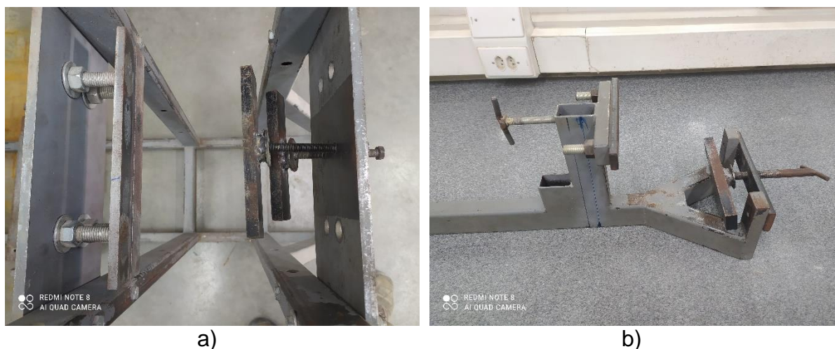
Figura 78 - Fixação do bloco inferior
