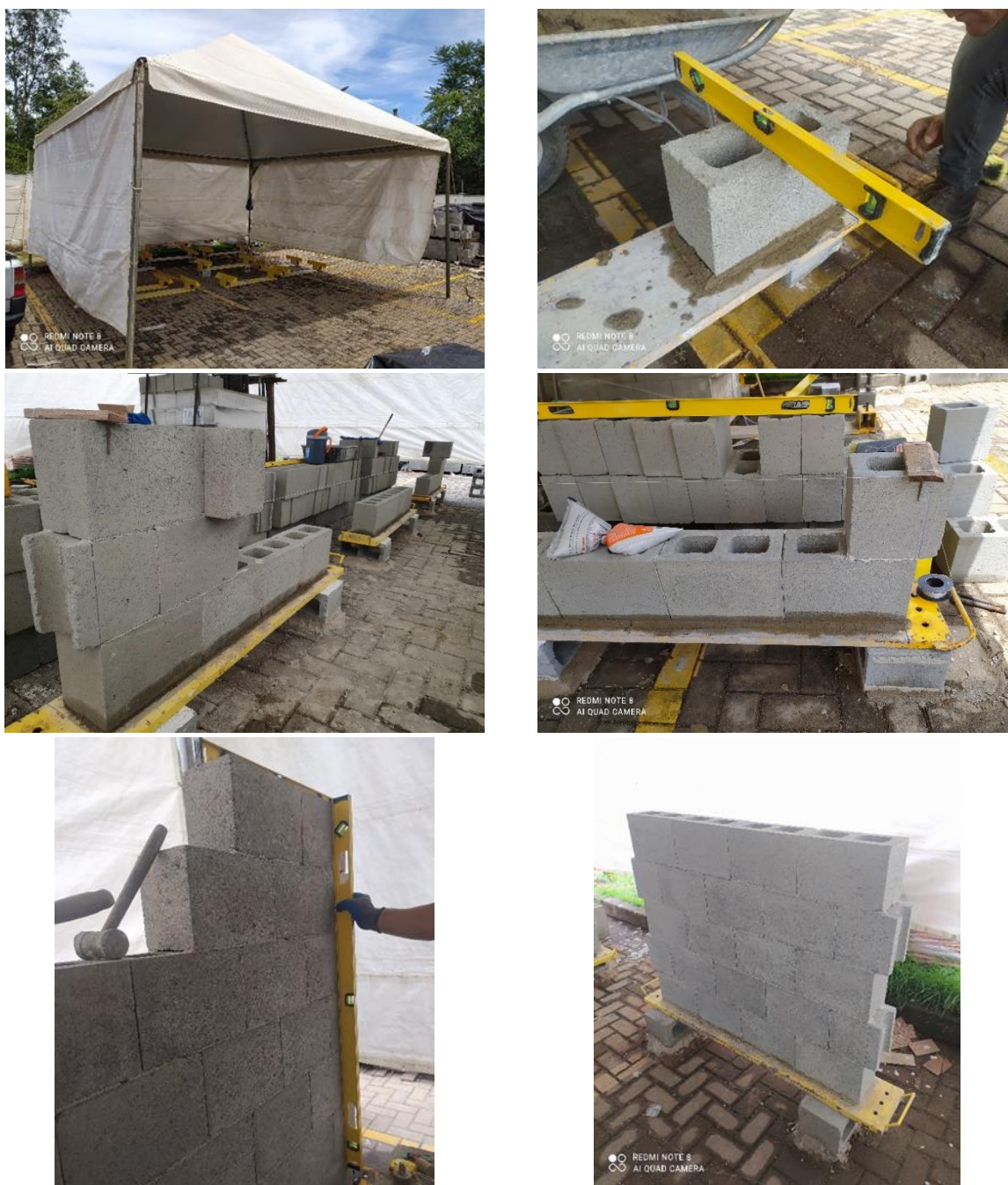
Figura 69 - Imagens da construção das paredes
