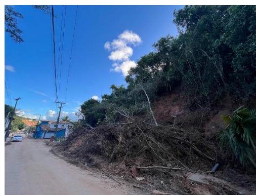
Foto 21: Desabamento, rua que liga o centro à Sapolândia, após a enchente (acervo pessoal).
