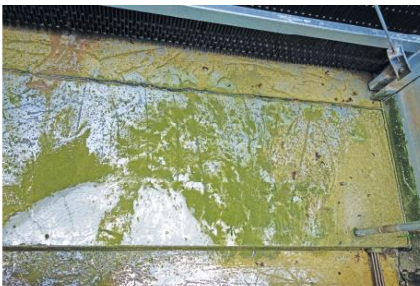
Figura 8 – Camada de algas na superfície da bacia de uma torre de resfriamento, com exposição direta à luz solar.
