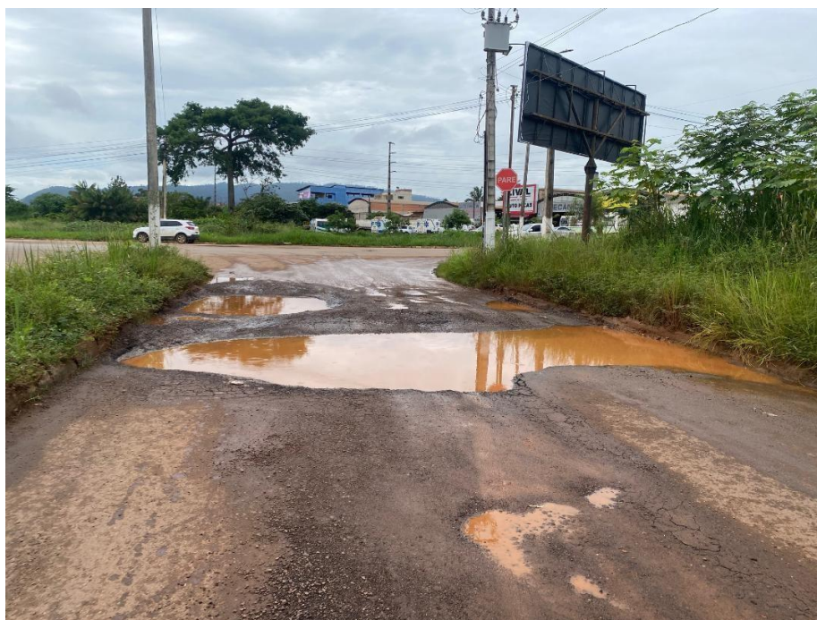
Figura 57. Asfaltamento próximo à Avenida Potiguar, no bairro dos Carajás
