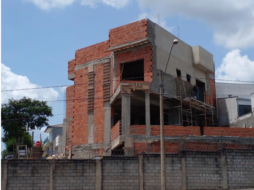
Figura 1 - Edifício em construção em loteamento na Zona Norte de Sorocaba
