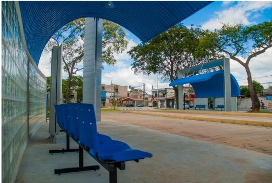
Figura 4 – Área de transferência – Rua Nogueira Padilha
