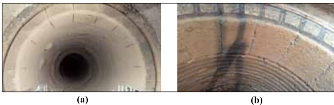
Figura 2.19 – Aspecto do revestimento em concreto refratário de alta alumina geopolimericamente ligado aplicados instalados em zonas de um forno rotativo de uma indústria de cimento, após (a) 7 meses e (b) 9 meses (adaptado de [22]).
