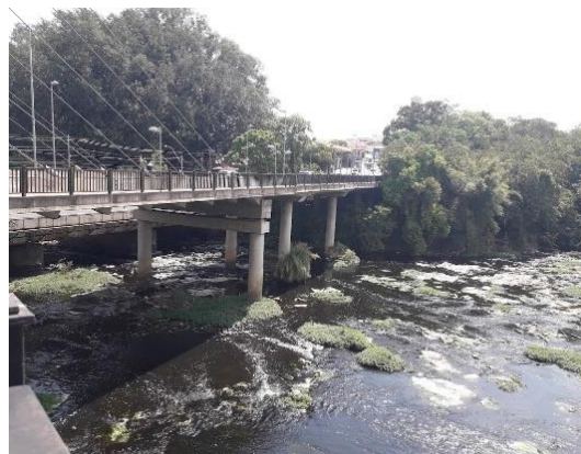
Figura D - 10: Nível do rio na Ponte "Arquiteto Caio Tabajara Esteves de Lima", durante a seca.
