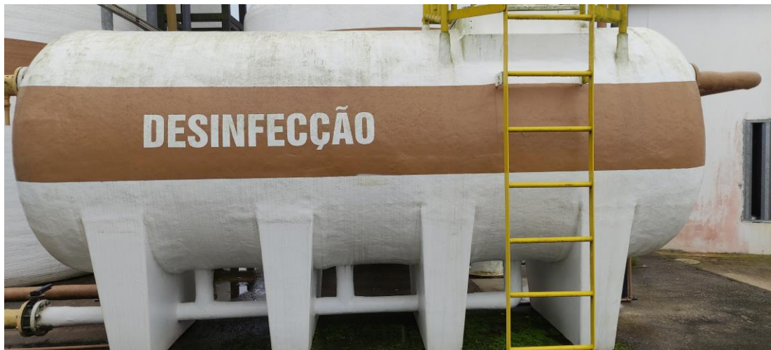
Figura 9 - Pós tratamento – Desinfecção com cloro (Fonte: Imagem do autor).
