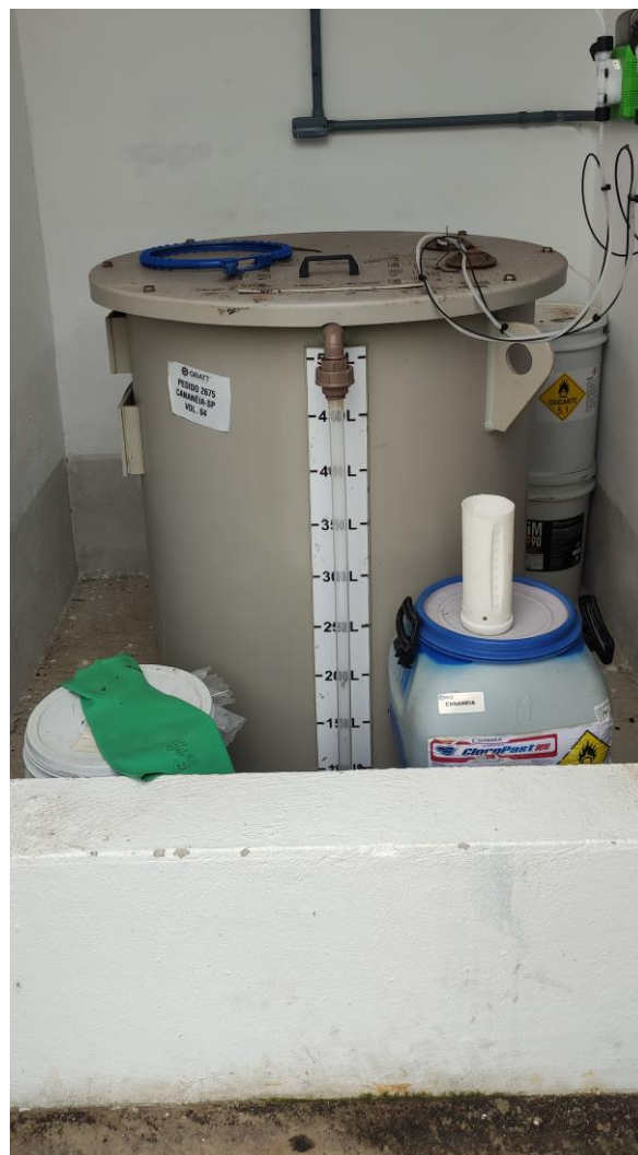
Figura 10 - Pós tratamento – Dosador de Cloro (Fonte: Imagem do autor).
