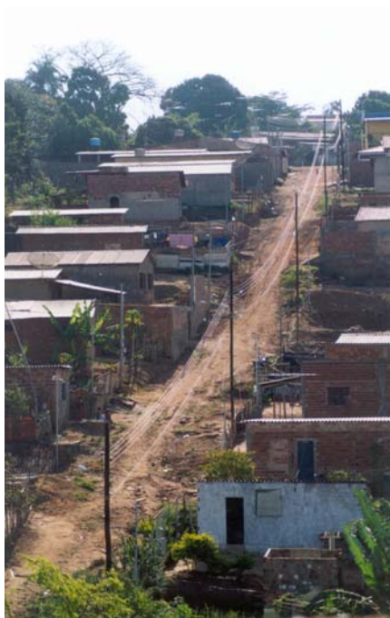
Figura 48: Ocupações inadequadas no fundo de vale do cór. Água Branca. Foto: Mota, L.C. (2003).
