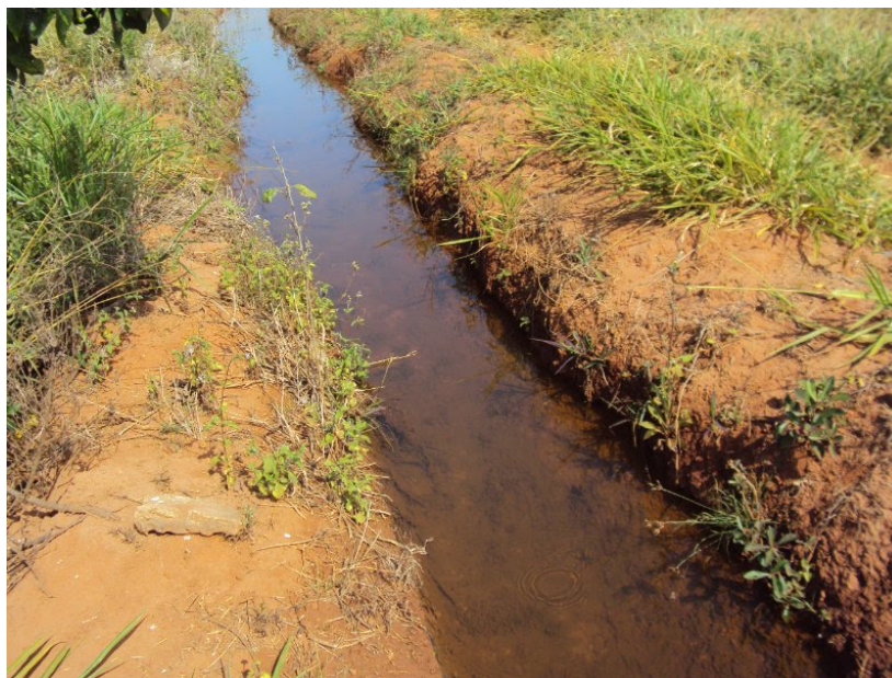
Figura 129: Duto de drenagem de tanque da Estação de Piscicultura Talarico, localizada no município de Tabatinga. Esse canal leva a água dos tanques para riachos próximos. (Fotos: Giseli Swerts Rocha, 2011).
