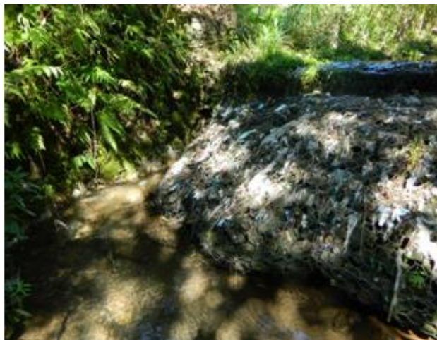
Figura 7 – Vista do Córrego São Rafael, localizado na porção superior da Bacia hidrográfica do rio Monjolinho - São Carlos, SP. À direita, ao lado do riacho visualiza-se uma estrutura de contenção formada cascalhos de pedra circundada por tela de ferro com fragmentos de plástico presos à tela (em azul).
