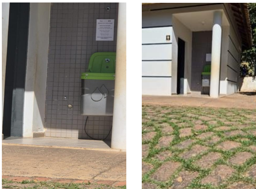
Figura 16: Banheiro e bebedouro
