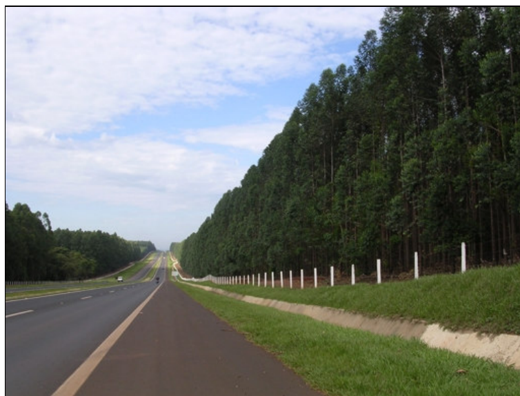
Figura 20: Vista da pista Sul da SP255 na altura do km 35, com a presença de plantação de Eucaliptos com grande estatura.
