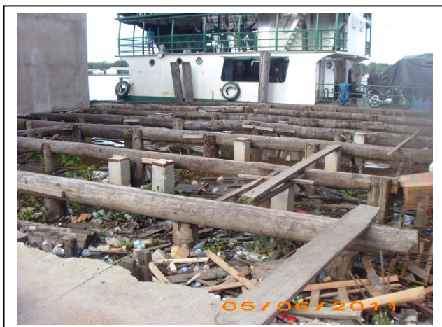
Imagem 34: Trapiche em construção, distrito Sede
