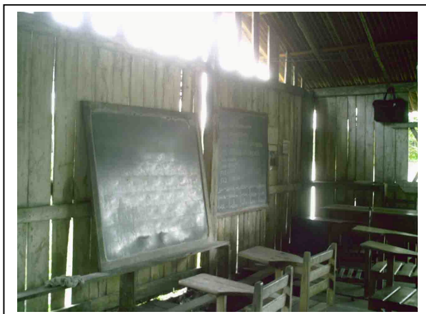
Imagem 40: Escola Municipal Nicolau Barbosa, distrito São Miguel Fonte: Material de pesquisa (2011)
