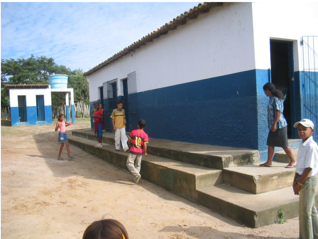
Figura 3: Área externa atrás da escola. Ao fundo o banheiro dos alunos, 2005 (arquivo pessoal).
