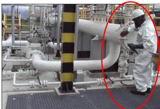
Figura 37 – Verificação da existência de vazamento no recebedor de PIG
