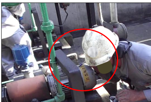
Figura 17 – Operador utilizando caneta esferográfica para atestar a vibração do motor
