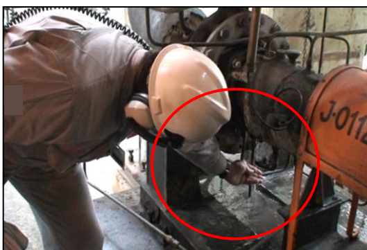
Figura 26 – Operador constata a viscosidade de líquido que vaza de bomba
