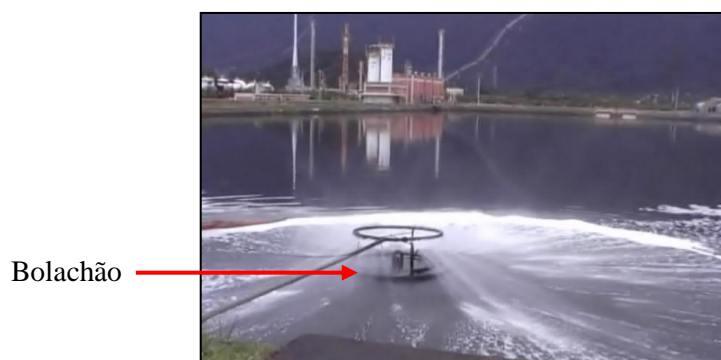
Figura 19 – Estrutura quebra-vórtice (bolachão)
