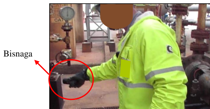
Figura 35 – Operador borrifando hidróxido de amônia na Bomba de HF
