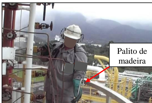
Figura 28 – Operador com palito de madeira para aferir a presença de HF
