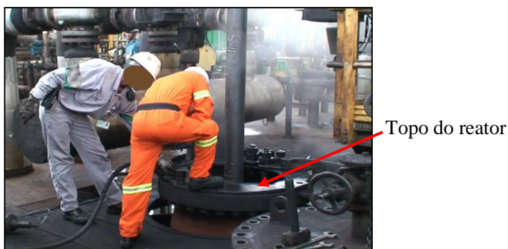
Figura 36 – Verificação da existência de coque no costado do reator
