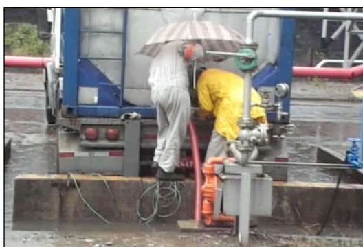
Figura 13 – Acoplagem do caminhão à tubulação de diesel
