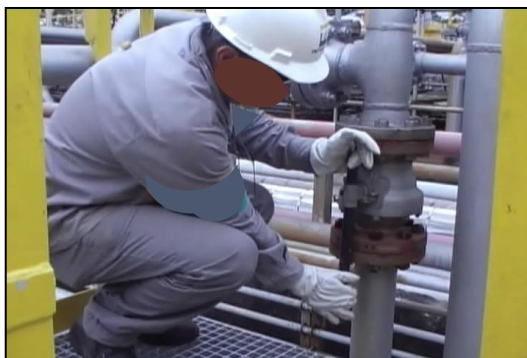
Figura 30 – Válvula em altura desfavorável à sua operação
