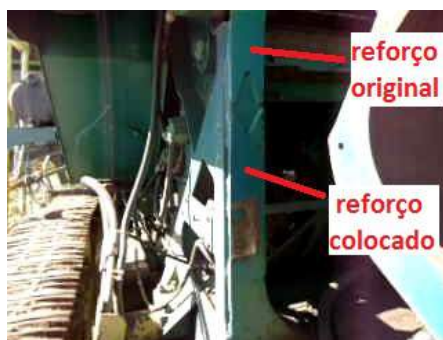
Figura 79. Reforços na estrutura John Deere 3522.
