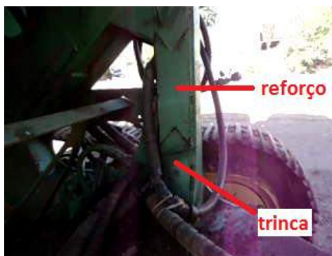
Figura 80. Reforços na estrutura John Deere 3522.
