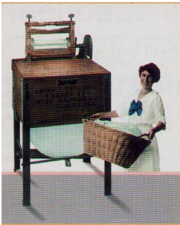
FIGURA 3.1: Máquina de lavar roupas com secagem por rolos, da Upton, oferecida na década de 20, pelo catálogo da Sears.
