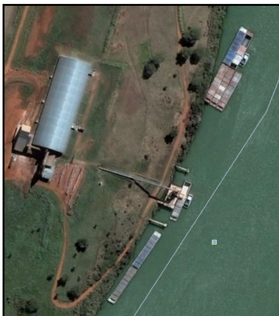
Figura 4.3: Carregamento de barça em terminal de São Simão (GO).
