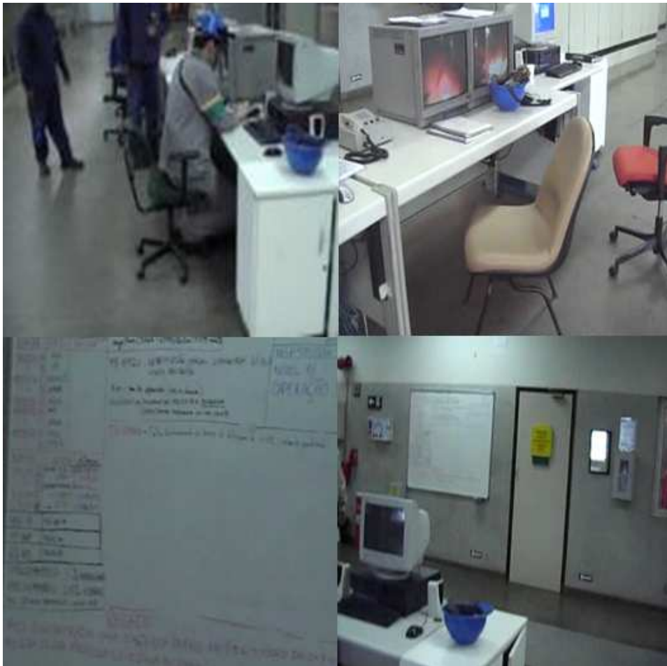
Figura 16 - Casa de controle local, CAFOR
