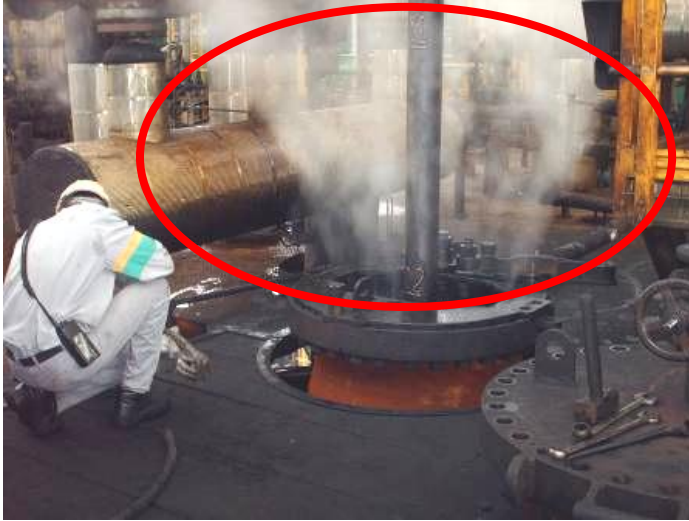
Figura 13 - Abertura do topo do reator
