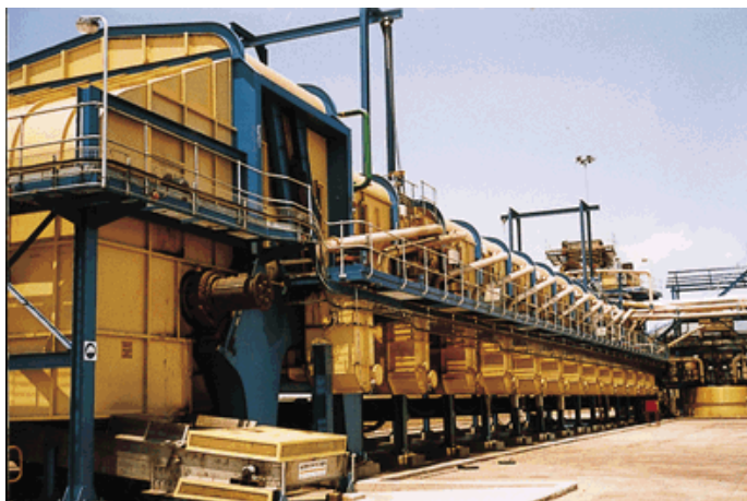
Figura 1: Imagem do difusor modular completo na usina
