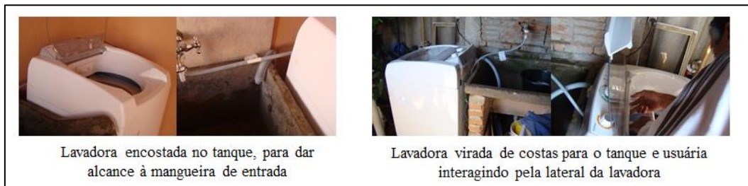
Figura 20 – instalação das lavadoras com mangueira de entrada de água que não alcançaram a torneira.
