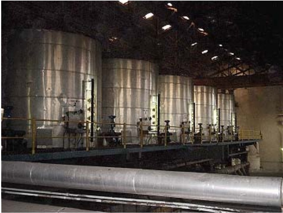
Figura 6.1: Cristalizadores de massa A - Setor de Cristalização da Usina São Martinho.
