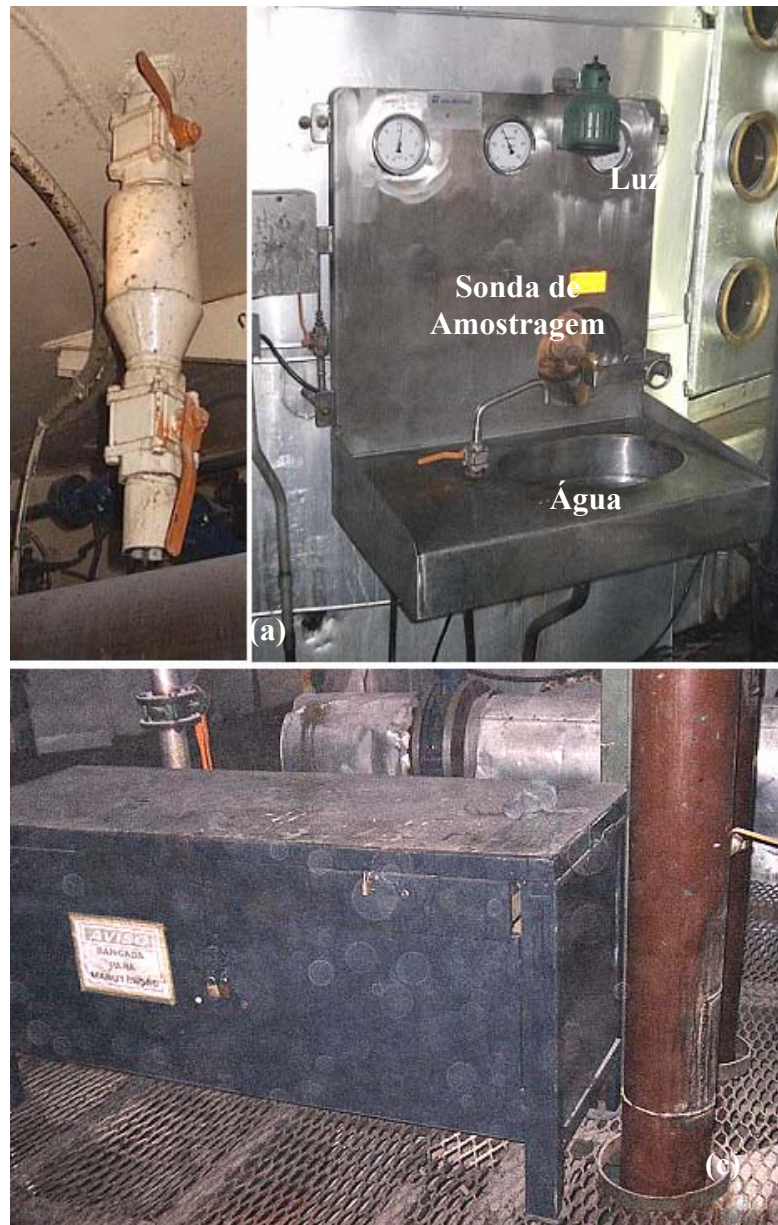
Figura 6.2: Detalhes do ambiente de trabalho: (a) Garrafa de amostragem, (b) Parte frontal do cristalizador 10 e (c) Balcão utilizado para alocação das amostras coletadas.
