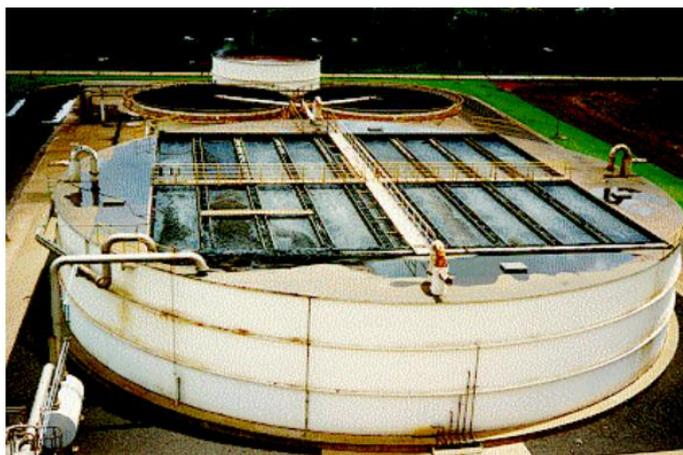
**Figura 4. 6:** Reator UASB termofílico utilizado no tratamento de vinhaça na Usina São Martinho, Pradópolis, SP.
