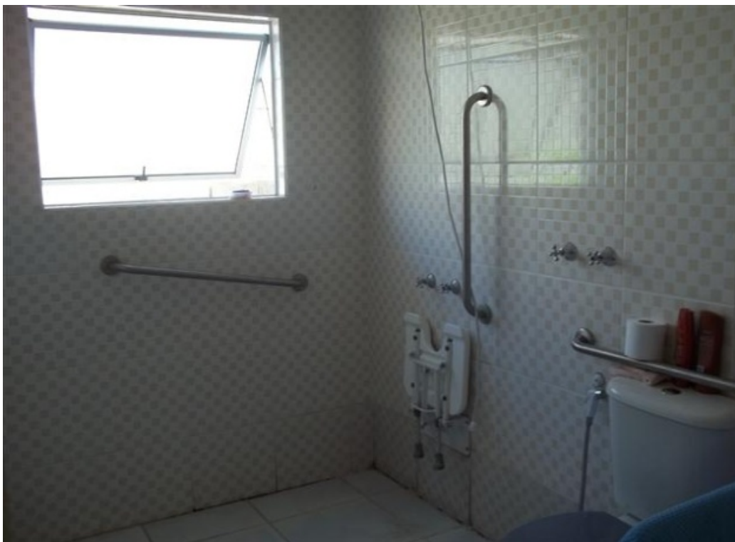
Figura 7 – Acessibilidade: barras de proteção no banheiro
