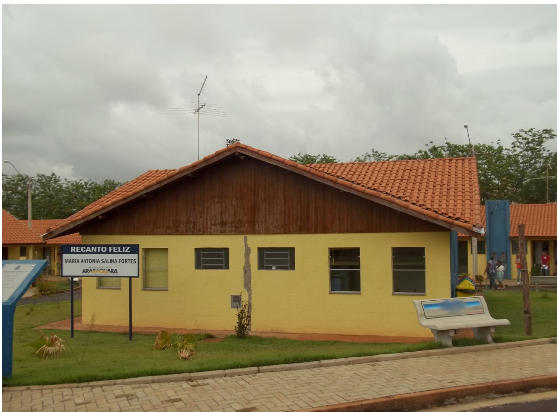
Figura 9 - centro de convivência: o espaço localizado no centro do condomínio. UFSCar, 2012.
