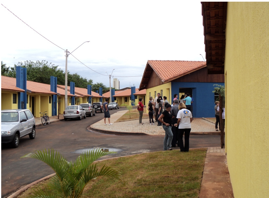
Figura 8 - : vista geral das casas: dia da inauguração. UFSCar, 2012.
