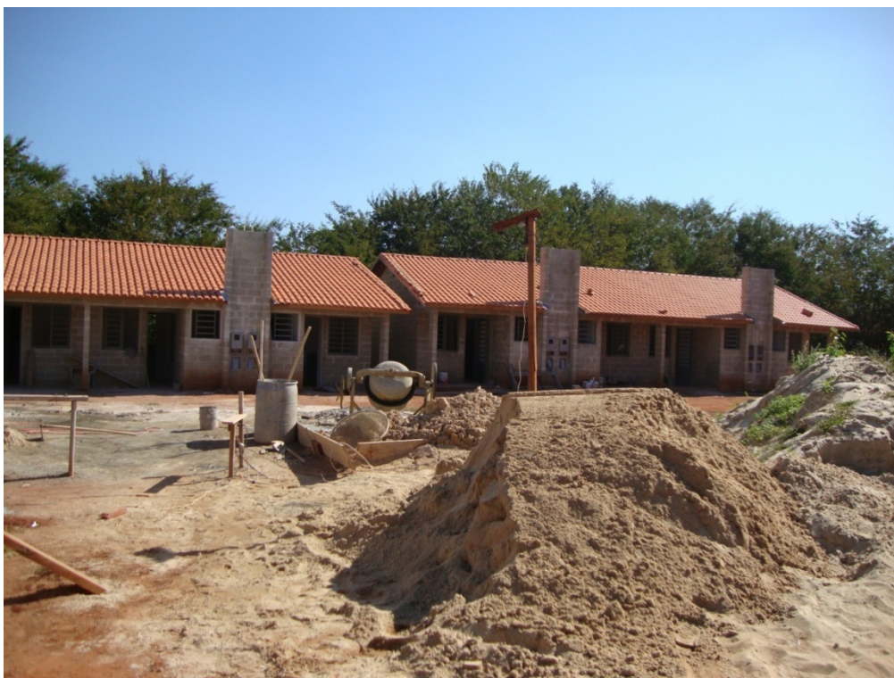
Figura 11 – Casas: obras do condomínio exclusivo para idosos (jul/2010)
