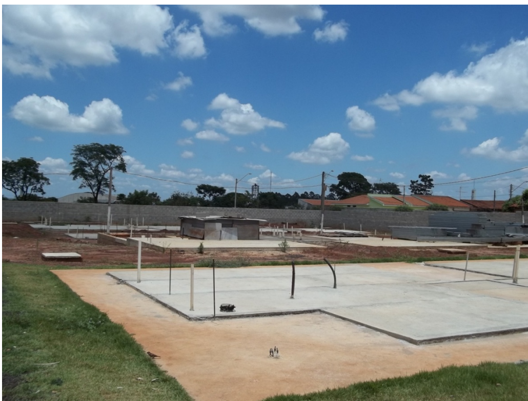
Figura 10 – Vista interna do terreno: as bases de algumas casas estão prontas
