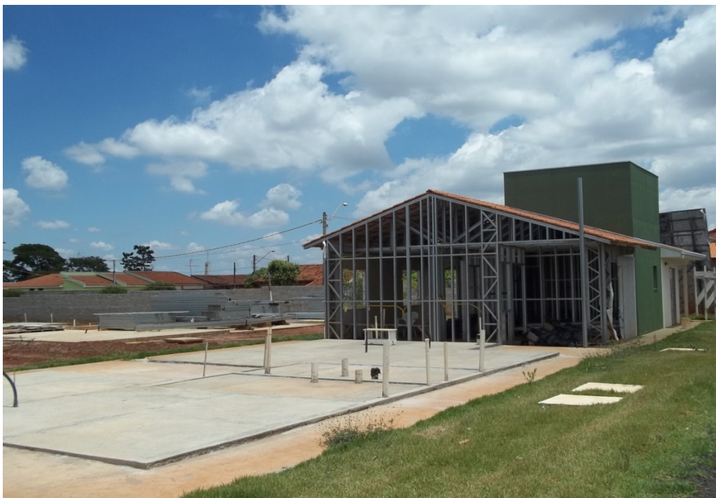
Figura 9-: Vista geral: parte interna do futuro condomínio e estrutura da casa-modelo
