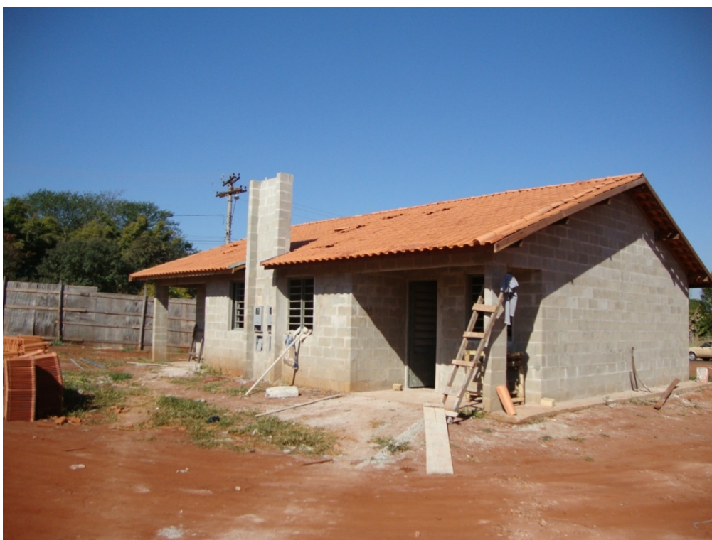
Figura 12 – Casas adaptadas: construção das duas casas adaptadas (jul/2010)
