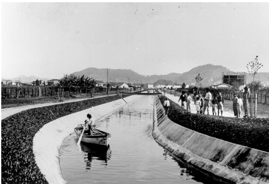
Figura 26 – Canal em Santos, primeiras décadas do século XX. Fonte: Fundação Arquivo e Memória de Santos.
