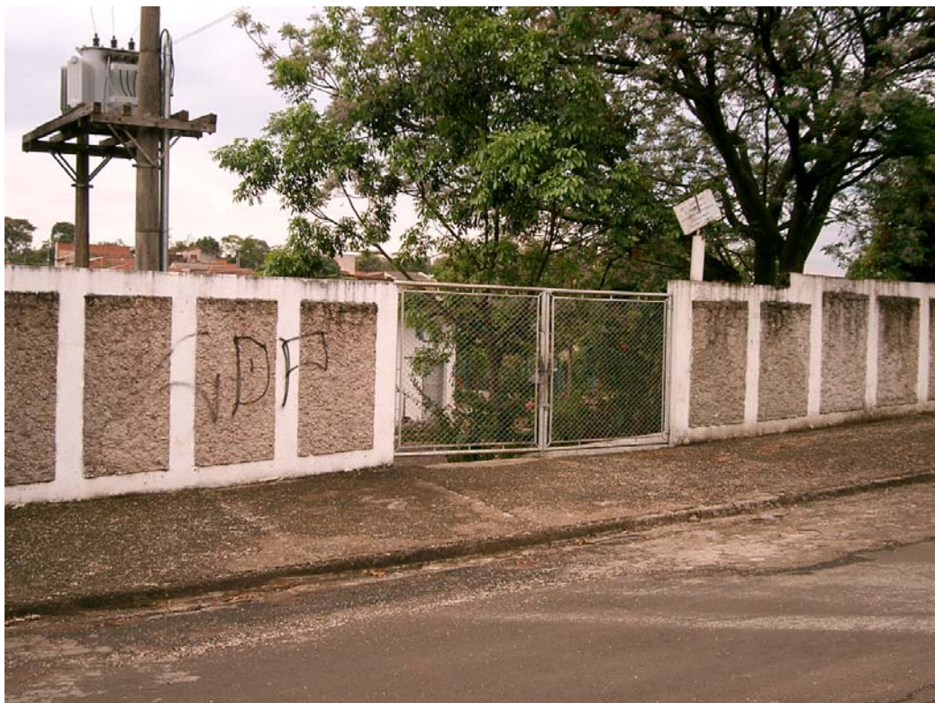
Foto 37 – Estação Elevatória de Esgotos – SABESP –
