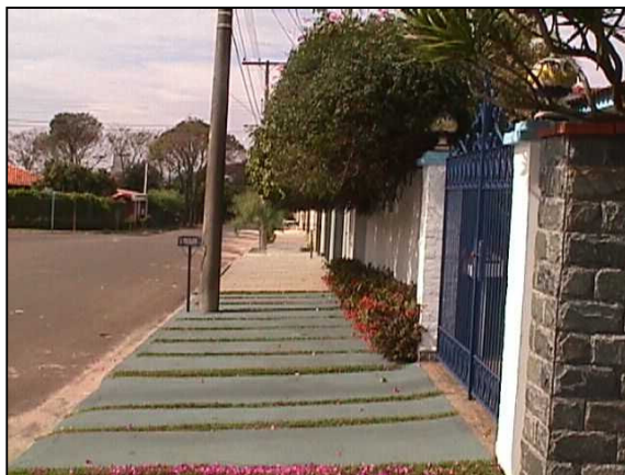
Figura 4.19: Galhos de árvores reduzindo a altura livre da calçada.
