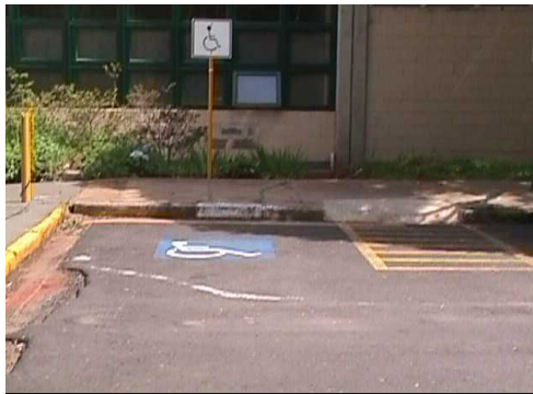
Figura 4.24: Sinalização vertical dirigida ao portador de deficiência – Vaga especial de estacionamento.
