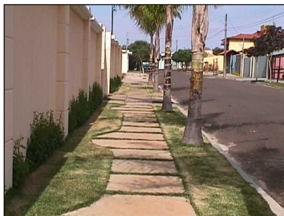
Figura 4.8: Utilização de grama na superfície da calçada.
