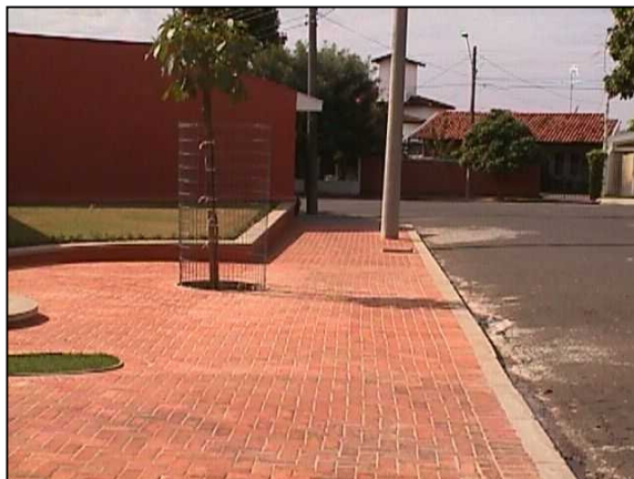
Figura 4.7: Calçada com superfície regular e antiderrapante.
