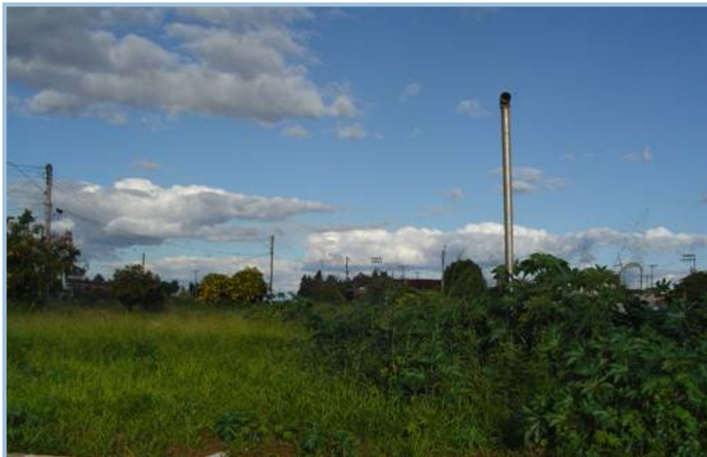
Figura 75 - Tubulação para emissão dos gases Foto: Olaia, F.B (2004).
