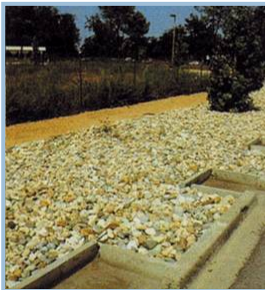
Figura 22 - Trincheira de infiltração – Lisboa
