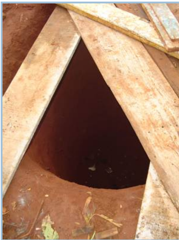
Figura 106 - Construção da Fossa pelo morador local Foto: Olaia, F. B. (2005)
