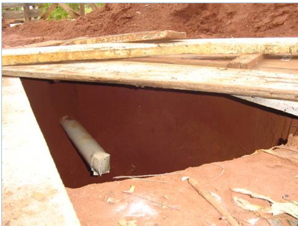
Figura 105 – Construção de Fossa Negra - Cano chanfrado Foto: Olaia, F. B. (2005)
