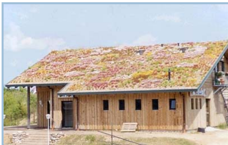
Figura 29 - Cobertura Intensiva - Alemanha Fonte: www.dachgaertner.de/
