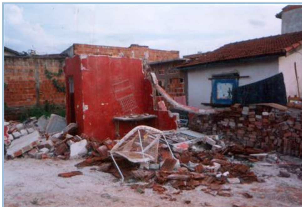
Figura 81 - Residência demolida Foto: Dias, B.P (2004)
