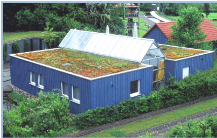
Figura 28 - Telhados Verdes - Alemanha Fonte: www.dachgaertner.de/
