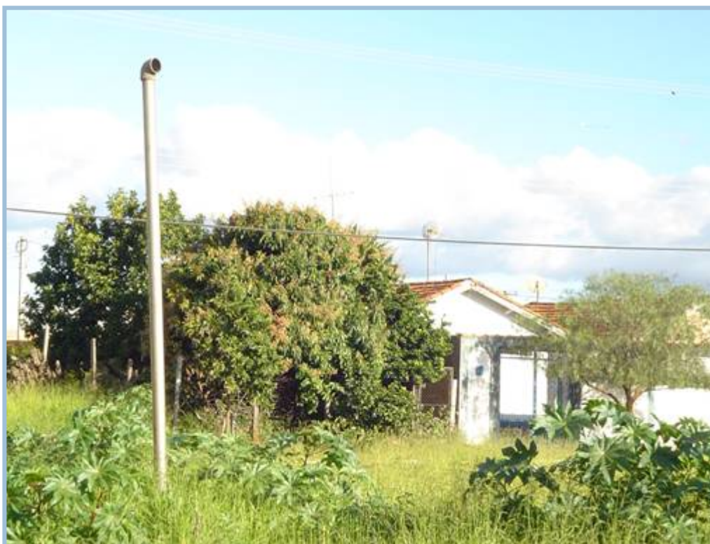
Figura 76 - Area de Lazer - Tubulação para emissão dos gases Foto: Olaia, F.B (2004).
