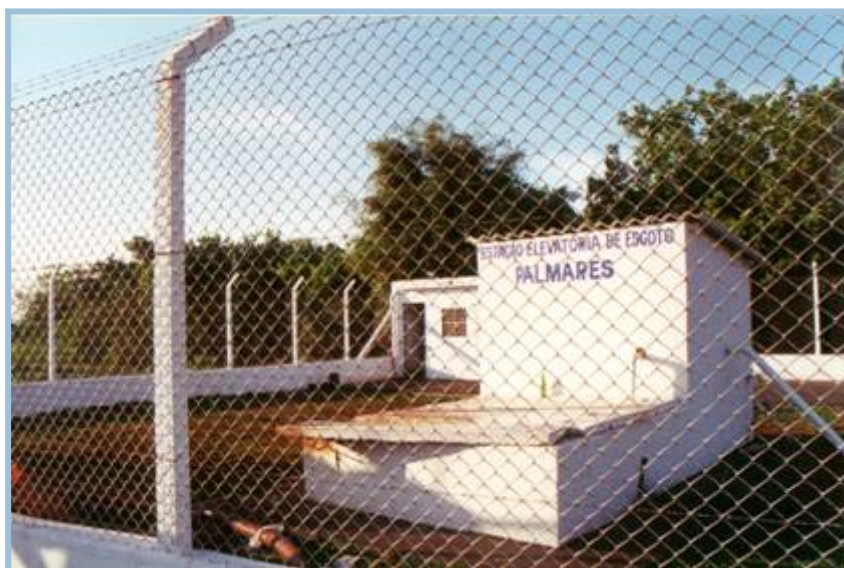
Figura 51 - Estação Elevatória Palmares Foto: Olaia, F.B. (2004)
