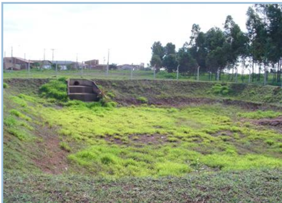
Figura 70 - Bacia de Contenção Foto: Olaia, F.B. (2004)
