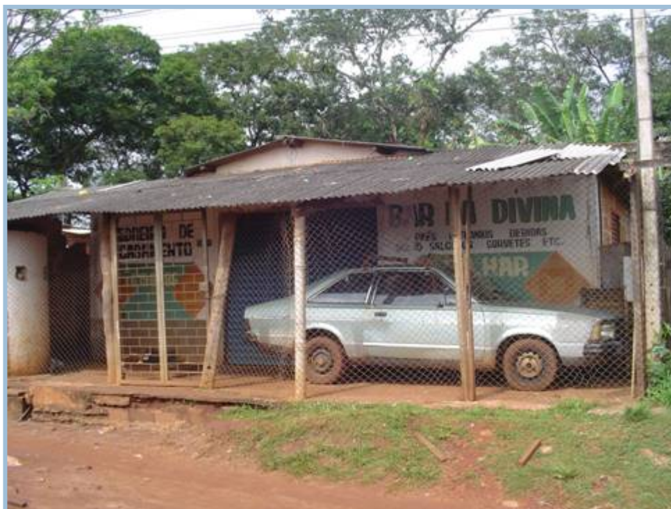
Figura 91 - Comércio e Prestação de Serviços - Favela Itápolis Foto: Olaia, F.B. (2005)
