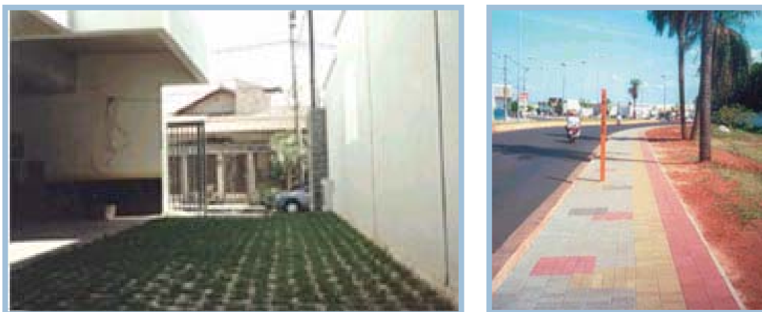
Figuras 24 e 25 - Pavimento intertravado de concreto- Gramado e Paginação Colorida Fonte: www.revistaprisma.com.br/urbanismo.htm RETENÇÃO
