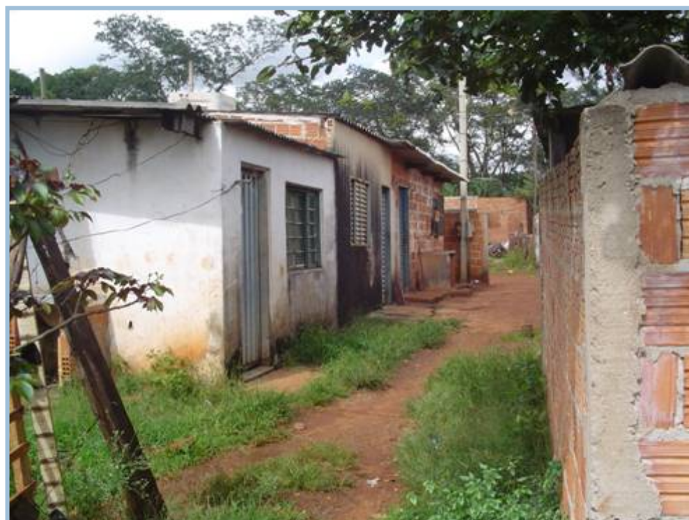
Figura 88 - Moradias - Favela da Mata Foto: Olaia, F.B, (2005)
