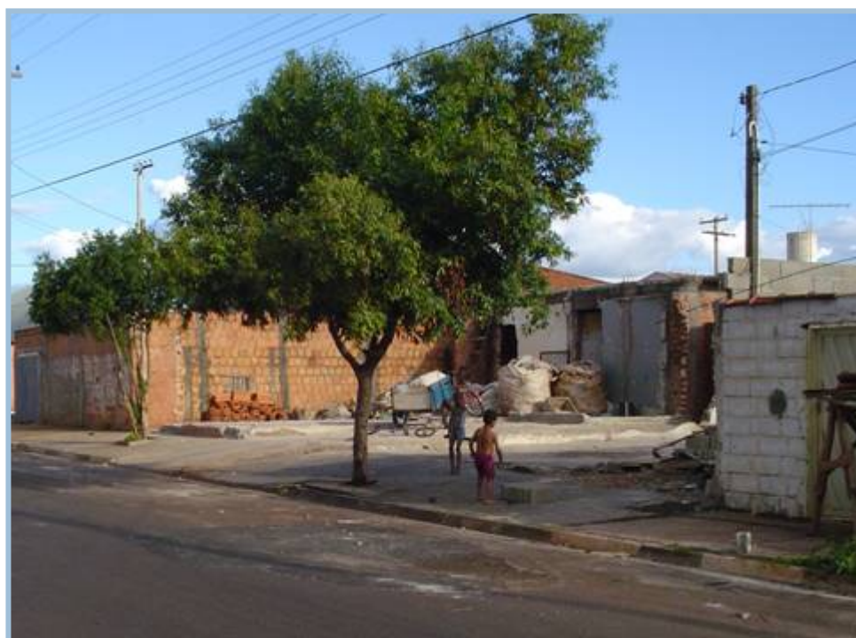
Figura 82 - Ocupações das Residências parcialmente demolidas Foto: Olaia, F.B (2004).
