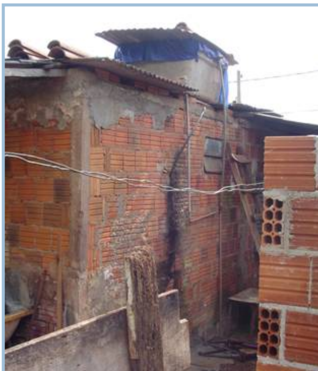
Figura 101 - Moradia com caixa d'água Foto: Olaia, F. B. (2005)
