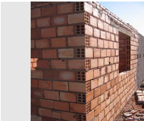
Utilização de alvenaria em bloco cerâmico com junta de amarração como alternativa construtiva adotada no assentamento pela facilidade de aquisição, em razão da oferta dos blocos cerâmicos.
