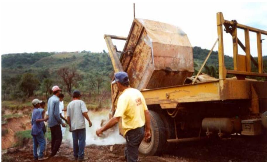
Figura 5.4: Lançamento dos RCD no bota-fora pelo caminhão da empresa
